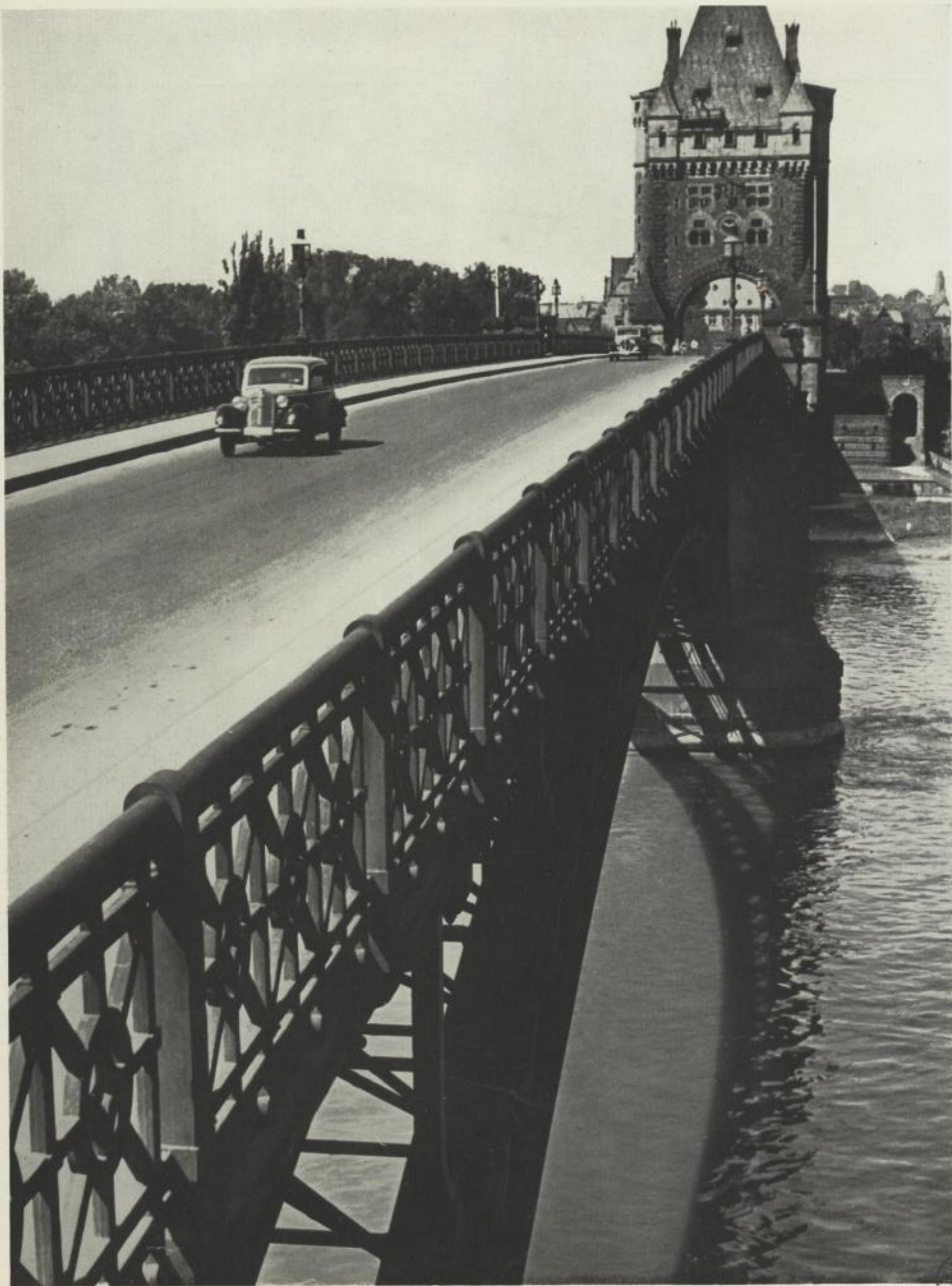
Die um 1900 erbaute Wormser Nibelungenbrücke verbindet das linksrheinische Hessen mit dem Odenwald. Noch heute heißt ein Distrikt jenseits des Rheines „der Rosengarten“.
