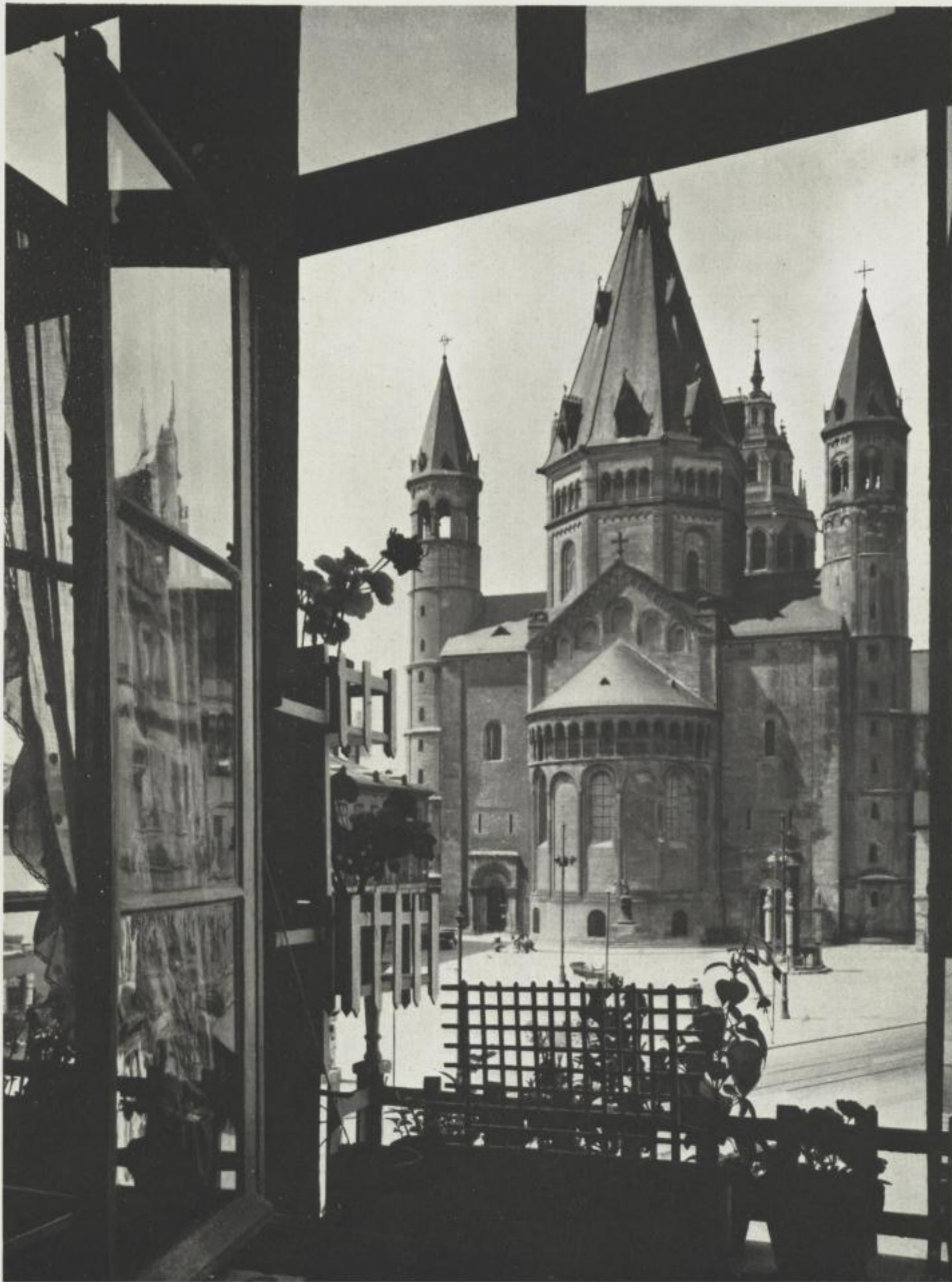
Der Mainzer Dom, dessen Bau 978 von Erzbischof Willigis begonnen wurde, drohte baufällig zu werden. Seine Fundamente wurden in den Jahren 1926 bis 1929 erneuert.
