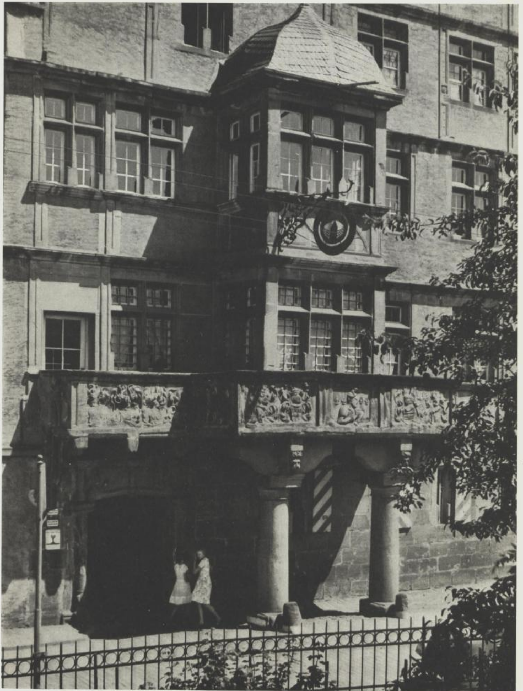
Das Hilchenhaus, das sich jetzt hinter dem Bahndamm von Lorch versteckt, ist eines der ältesten Wohngebäude, die am Rhein noch erhalten sind.
