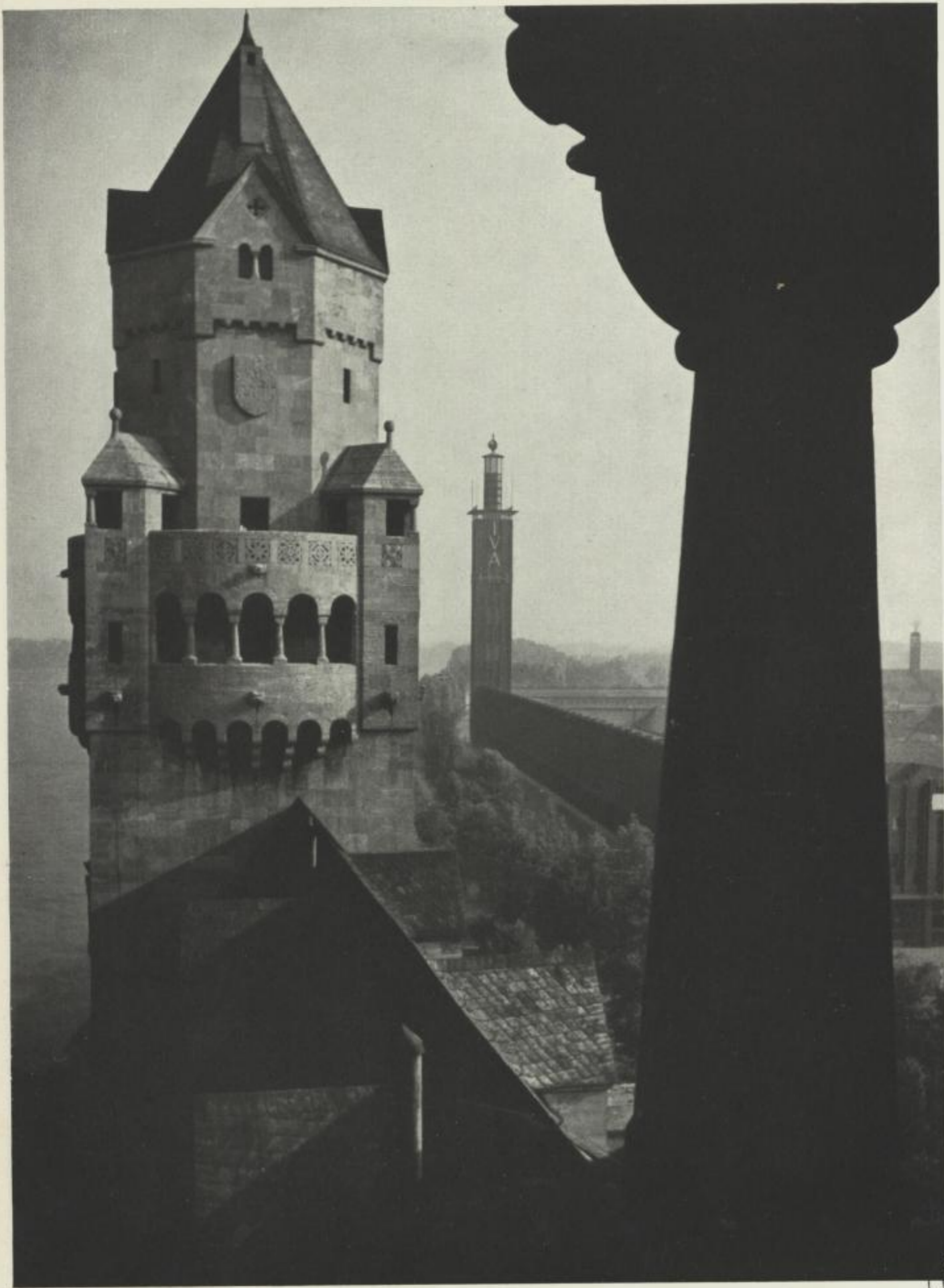
Zu den neuromanischen Ecktürmen der Kölner Hohenzollernbrücke gesellt sich der schlanke Turm der Messehalle.
