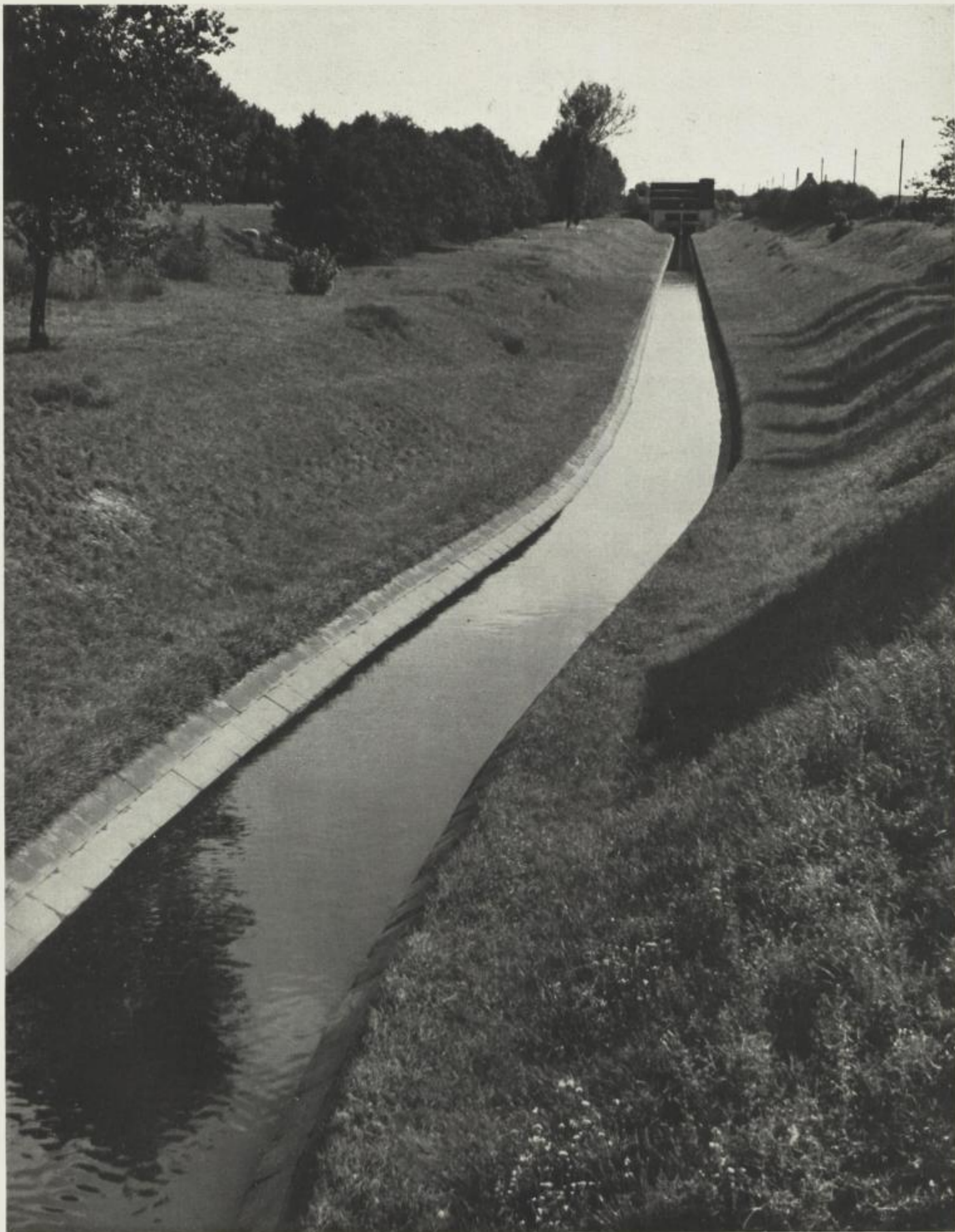
Durch das grasbewachsene Bett der alten Fossa Eugenia zieht sich jetzt die scharfge- schnittene Rin- ne des neuzeit- lichen Wasser- grabens.
