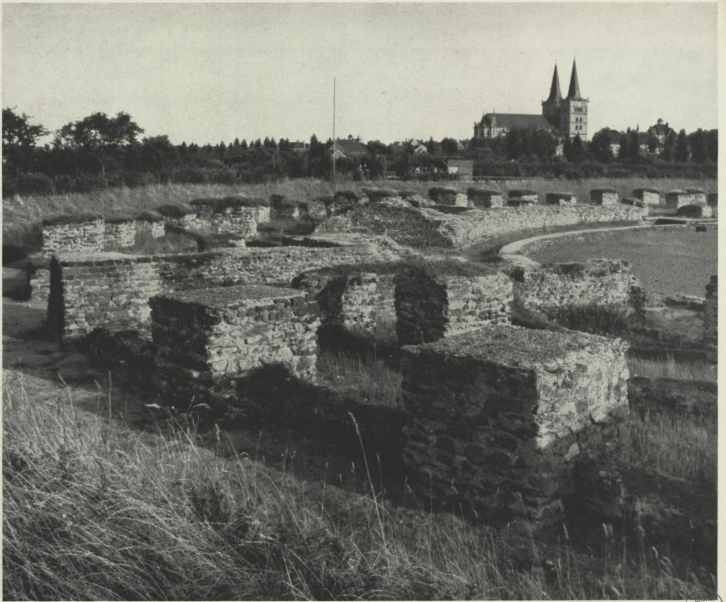
Nicht weit vom Rheinufer gräbt man bei Xanten ein römisches Amphitheater aus.
