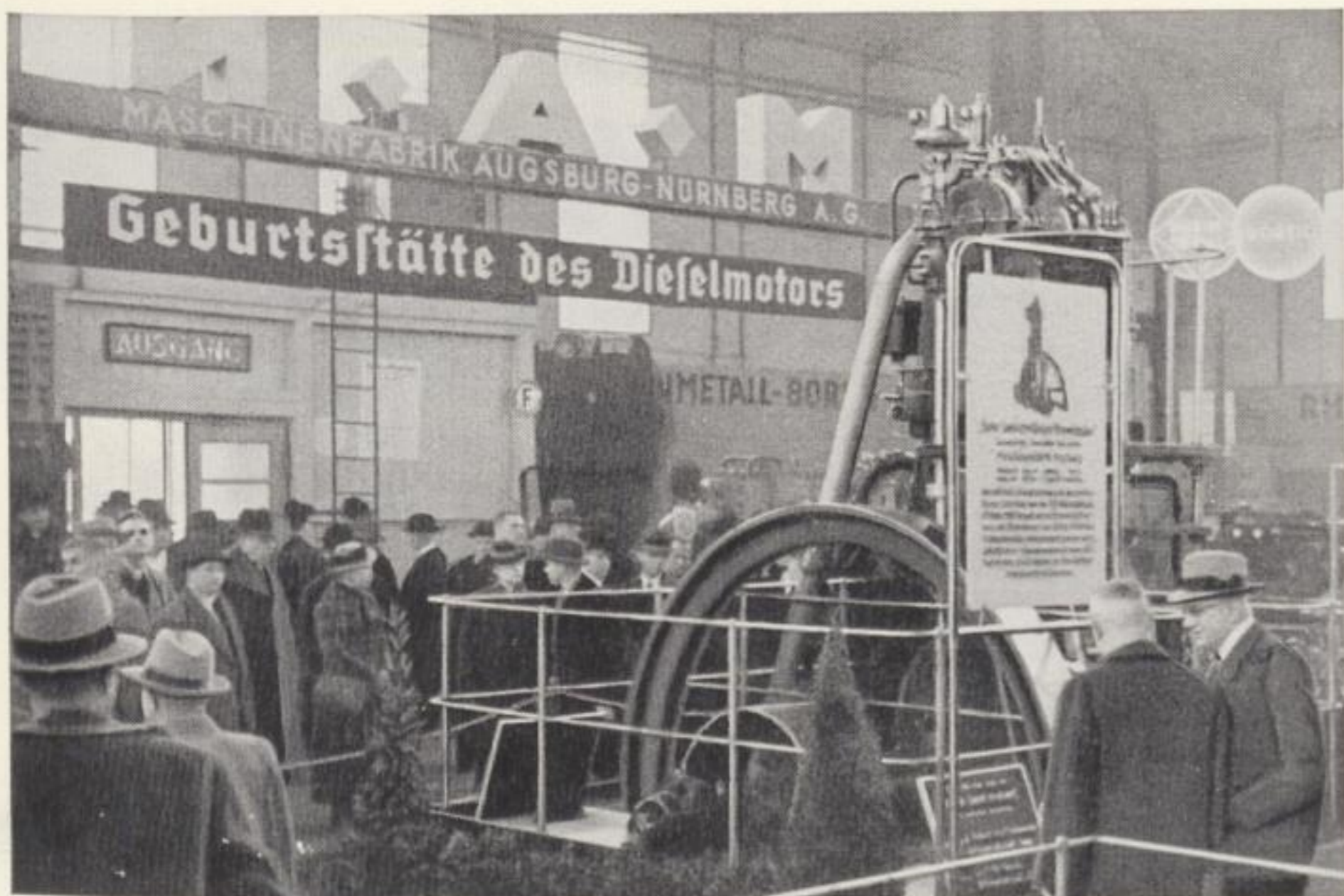
Der erste betriebsfähige Dieselmotor auf der Großen Technischen Messe und Baumesse Leipzig 1938 im Kreise modernster Dieselmotoren. Dieser erste Dieselmotor der Welt entstand in den Augsburger Werkstätten der MAN in den Jahren 1893/97 und entwickelte bei einem Kolbendurchmesser von 250 mm und einem Hub von 400 mm eine Leistung von 20 PSe (MAN, MASCHINENFABRIK AUGSBURG-NÜRNBERG AG)
