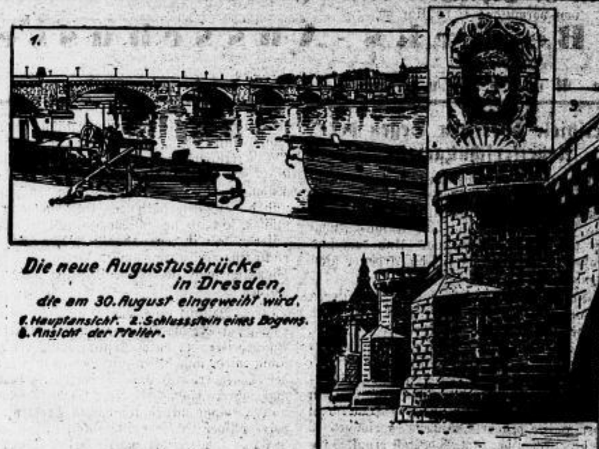
Die neue Augustusbrücke in Dresden, die am 30. August eingeweiht wird. 1. Hauptansicht. 2. Schlussstein eines Bogens. 3. Ansicht der Pfeiler.
