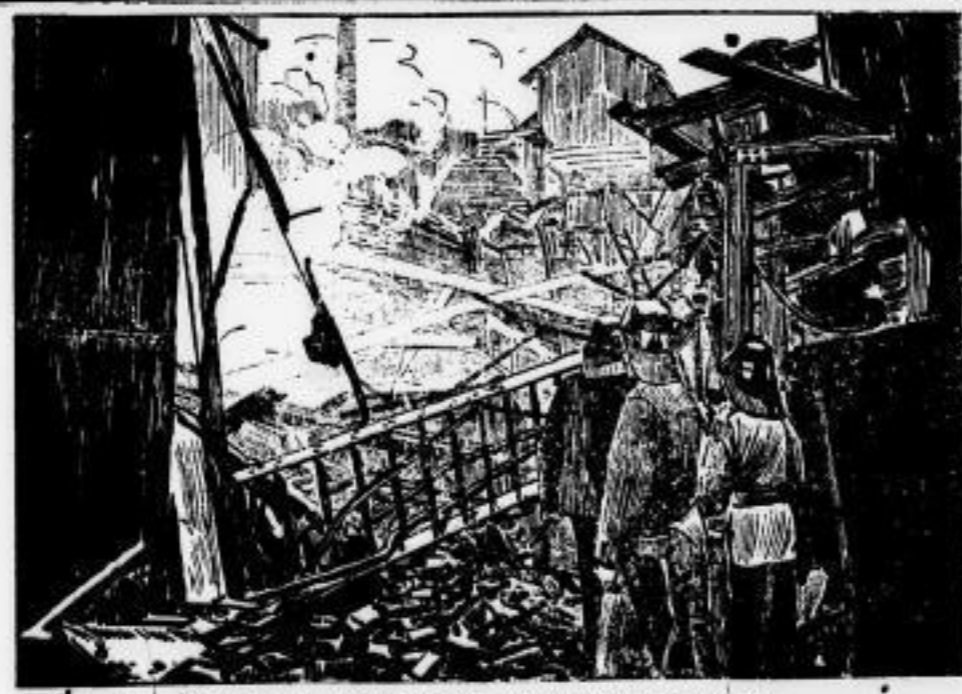
Die Explosionskatastrophe in Berlin-Rummelsburg. Die Zerstörung bei den Maschinenarbeiten in der geschlossenen Maschinenfabrik.
