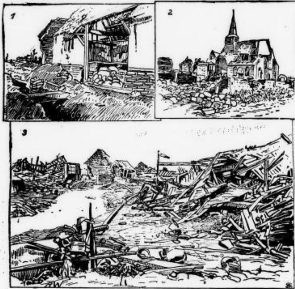
1. Das zerstörte Kamek. 2. Zerstörte Häuser in Wachsen. 3. Kirchentrümmer von Bequincourt.
