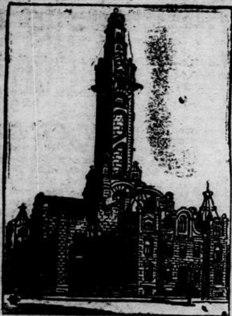
Das neue Heizwerk in Dresden.
