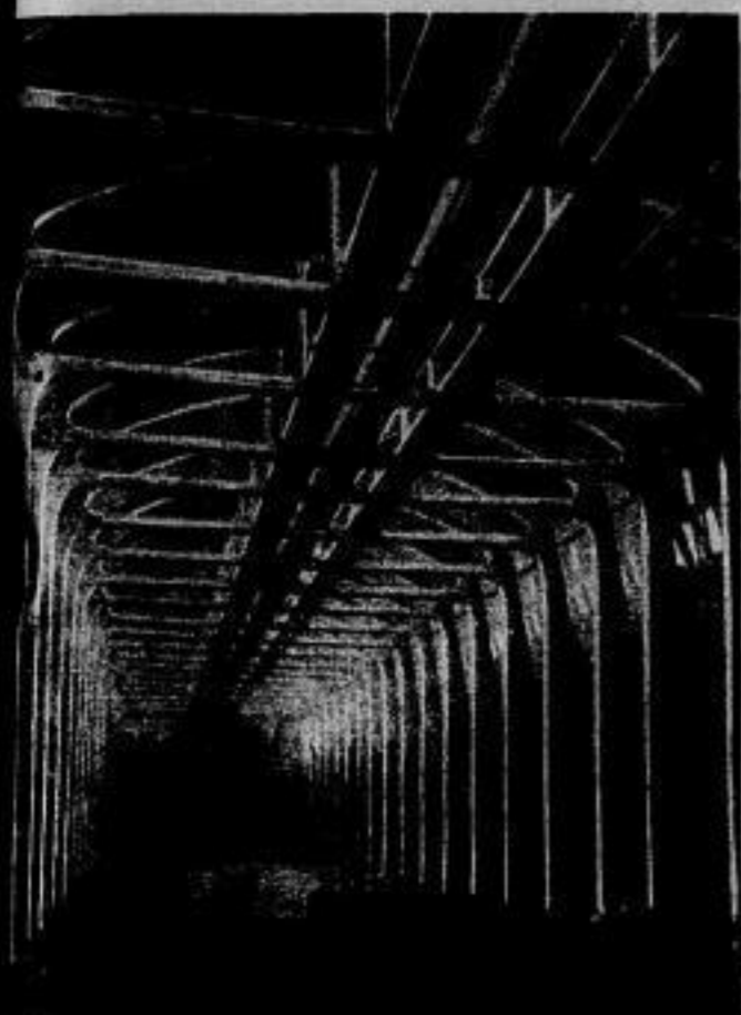
Deutsche Technik im Auslande Eisenbetonhalle zur Aufbewahrung von Rohschwefel, die von der Firma Weyss & Freytag, Frankfurt a. M., in Marseille erbaut wurde. Länge 100 m, Breite 20 m, Höhe 15,5 m, Fassungsvermögen 25000 cbm (Preß-Photo)
