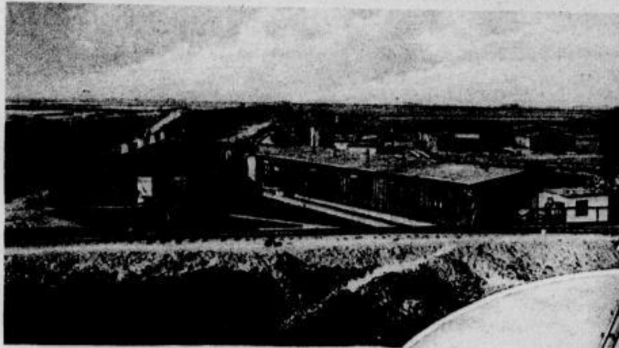
Wohnbaracken der am Dammbau beschäftigten Arbeiter
