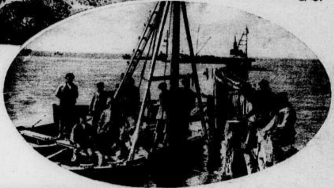
Rechts (Oval): Beim Bau der Spundwände zur Anlage der Steinumkleidung des Dammes
