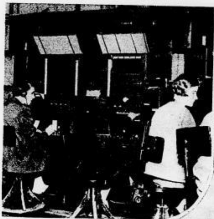
Die direkte Fernsprechverbindung zwischen England und Amerika wird immer mehr in Anspruch genommen, trotz der naturgemäß erheblichen Gebührensätze. Unser Bild zeigt das Vermittlungsamt New York, das die Verbindungen des transatlantischen Dienstes herstellt (Pressephoto)
