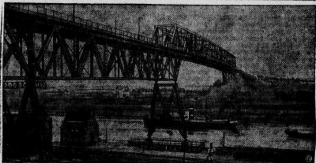
Am 3. Juni des Jahres 1887 legte Kaiser Wilhelm I. den Grundstein zu der großen Wasserstraße, die, quer durch die Schleswig-Holstein-Halbinsel gehend, eine Verbindung zwischen der Nord- und Ostsee schafft. — Unser Bild zeigt die Holtenauer Brücke über den Nordostsee-Kanal.
