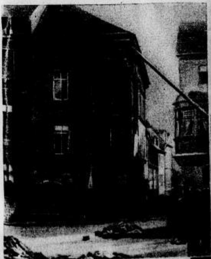
Ein Haus in Altenburg in Thüringen wurde infolge eines Wasserrohr-Bruches vom Wasser unterpflutet und stürzte ein. Alte unterirdische Klosettgänge begünstigten die Ansammlung der Wassermengen Dr. Kuhnert, Altenburg
