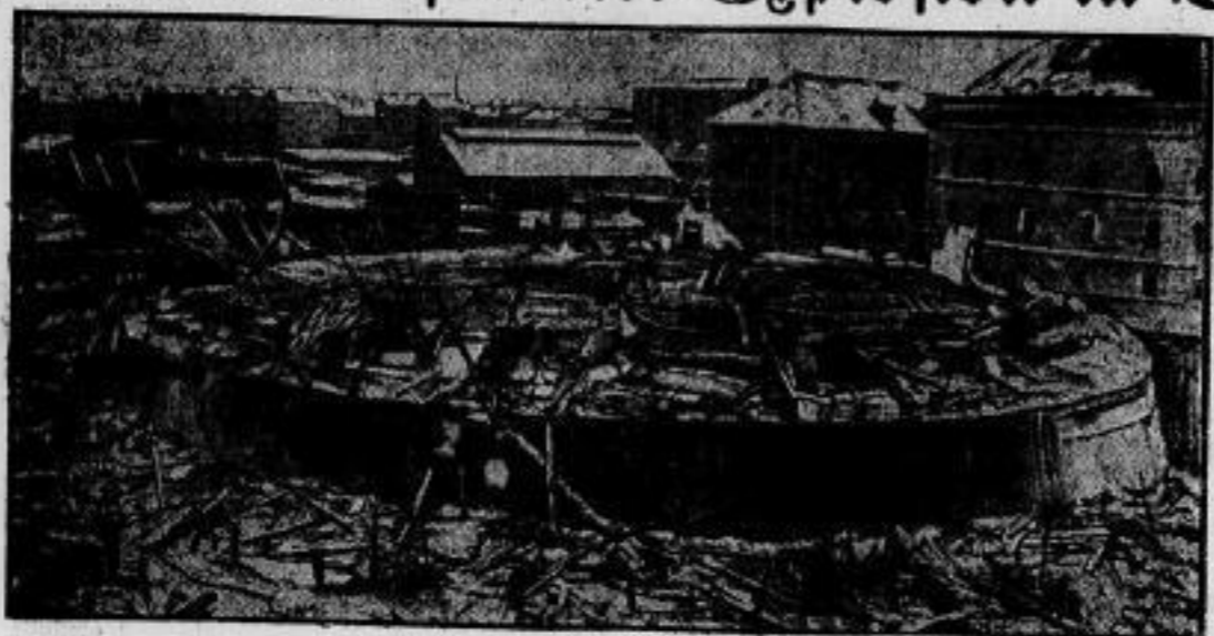
Unter Bild zeigt die Ueberreste des zerstörten Gasometers. Im Vordergrund rechts der unversehrt gebliebene zweite Gasometer, der einen Eindruck von der Größe seines explodierten Nachbarn vermittelt.
