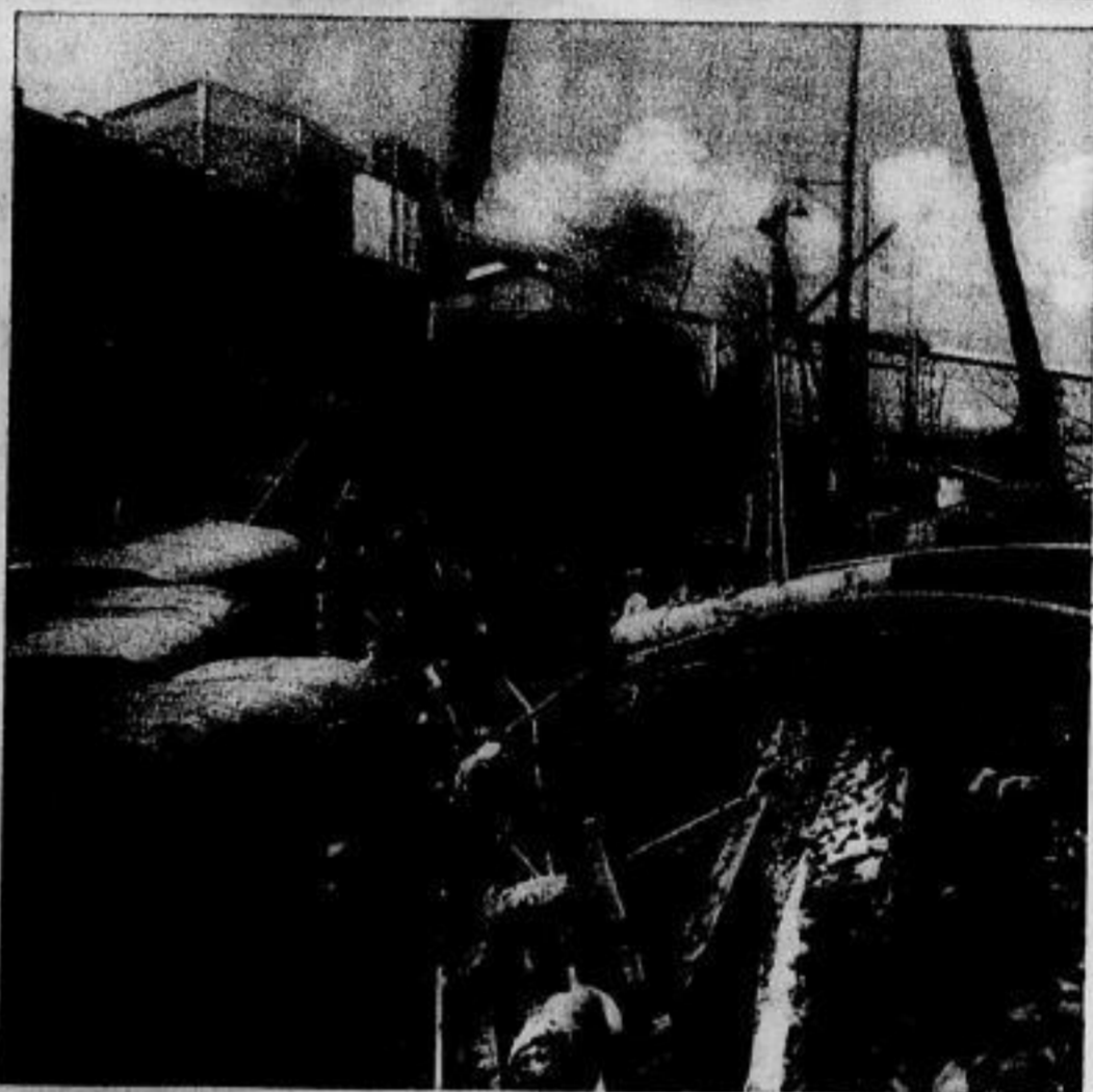
Der Einsturz einer großen Förderrammbücke im sächsischen Braunkohlenrevier forderte ein Todesopfer und mehrere Verletzte. Auf der Grube Dora-Gelene in Groß-Böffen bei Lobstädt brach die Brücke zusammen, als ein voller Förderzug sie überfuhr. Die Besatzung des Zuges konnte sich zum größten Teil durch Abspringen retten L. B. D.
