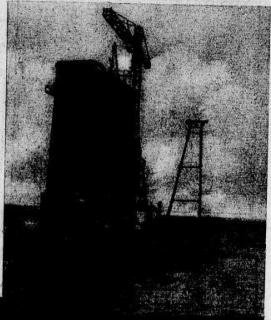
Rechts: Der Senk­kasten ruht fest auf dem Grund, auf ihm ist der eigentliche Pfeiler schon fast fertig errichtet
