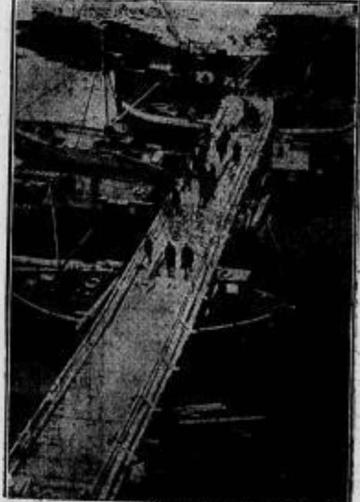
Schnelle und sichere Arbeit unserer Pioniere Von den zurückgehenden Norwegern war auch an dieser Stelle eine große Eisenbahnbrücke gesprengt worden. In schneller und sicherer Arbeit unserer Pioniere wurde jedoch diese Holzbrücke hergestellt, über die jetzt darauf auch die schweren Wagen und Geschütze rollen konnten. (Scherl-Bilderdienst-M.)
