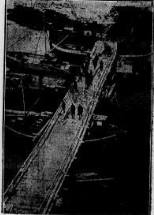
Schnelle und sichere Arbeit unserer Pioniere Von dem zurückgehenden Norwegern war auch an dieser Stelle eine große Eisenbahnbrücke gesprengt worden. In schneller und sicherer Arbeit unserer Pioniere wurde jedoch diese Holzbrücke hergestellt, über die jetzt darauf auch die schweren Wagen und Geschütze rollen konnten. (P.R. Scherl-Scherl-M.)
