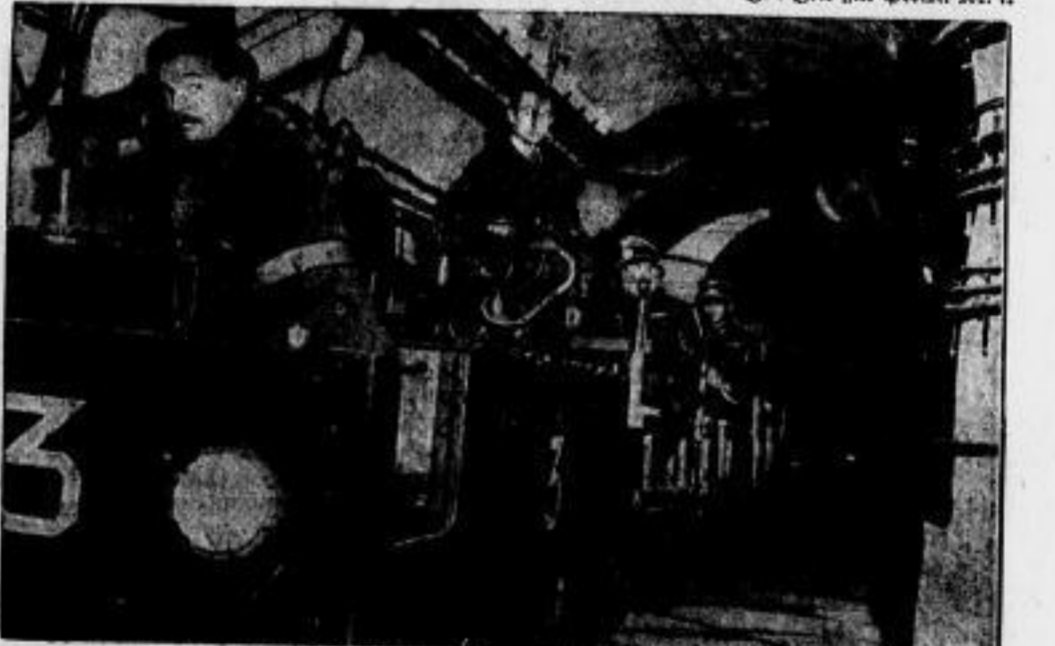
Im Wert Hakenberg der Maginot-Linie Unterirdische Kilometerlange Gänge verbinden die einzelnen Panzerkuppeln und Geschützstände dieses Großwerkes der Maginot-Linie. Die deutsche Uebernahmungskommission benutzt, wie unser Bild zeigt, die von französischen Soldaten gefeuerte Werksbahn, die früher vorwiegend dem Munitionstransport diente. (H.A. Sehnardt-Presse-Bild-Zentrale-M.)
