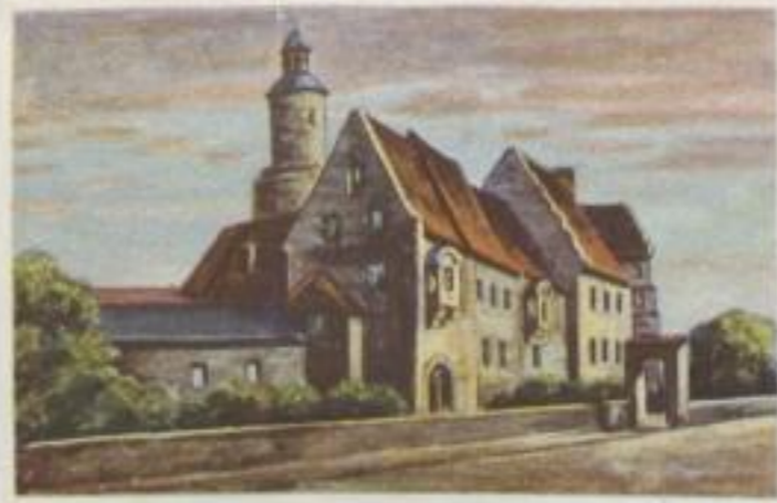
BÖDINGEN Wasserburg, deren Vorburg und Hauptburg durch Graben getrennt sind. Die Hauptburg mit nahezu runder Grundrißform stammt noch weithin aus romanischer Zeit: Bergfried, Ringmauer, Palas und Kapelle aus dem Anfang des 13. Jahrhunderts. Die übrigen Gebäude spätmittelalterlich oder aus dem 16. Jahrhundert.
