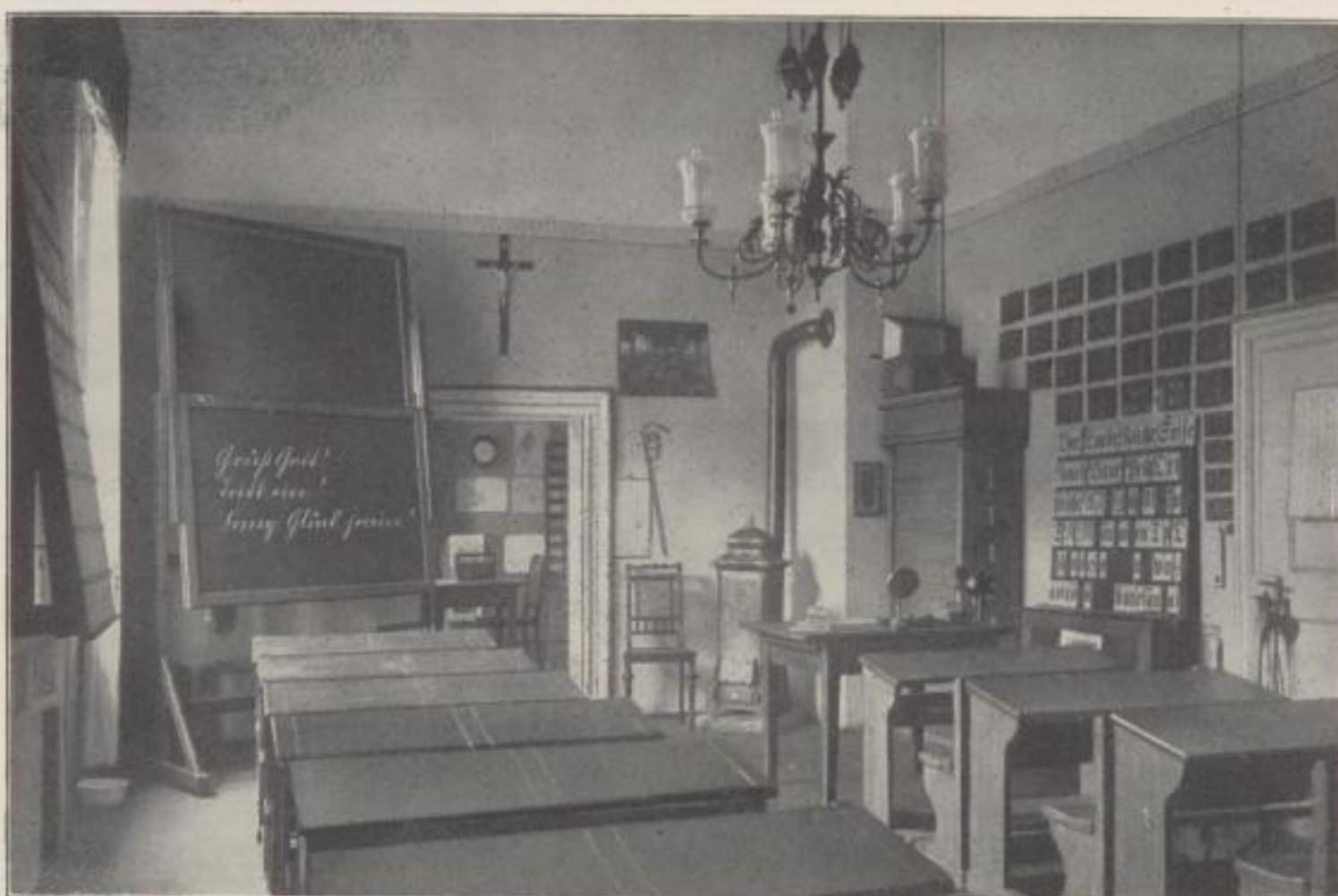
Abb. 1. Notquartier der Hilfsschule.
