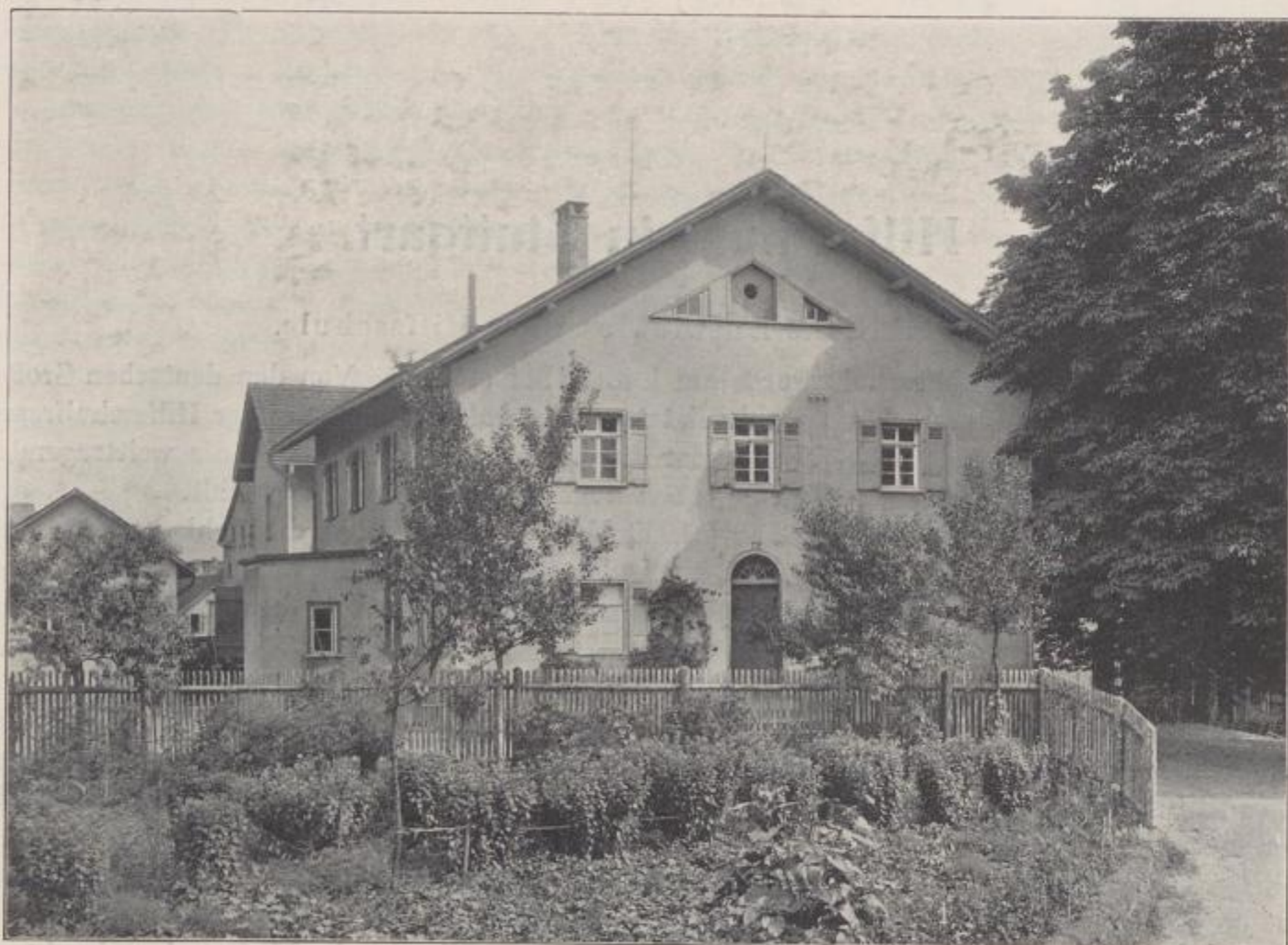
Hofschulgebäude in Stuttgart-Cannstatt.
