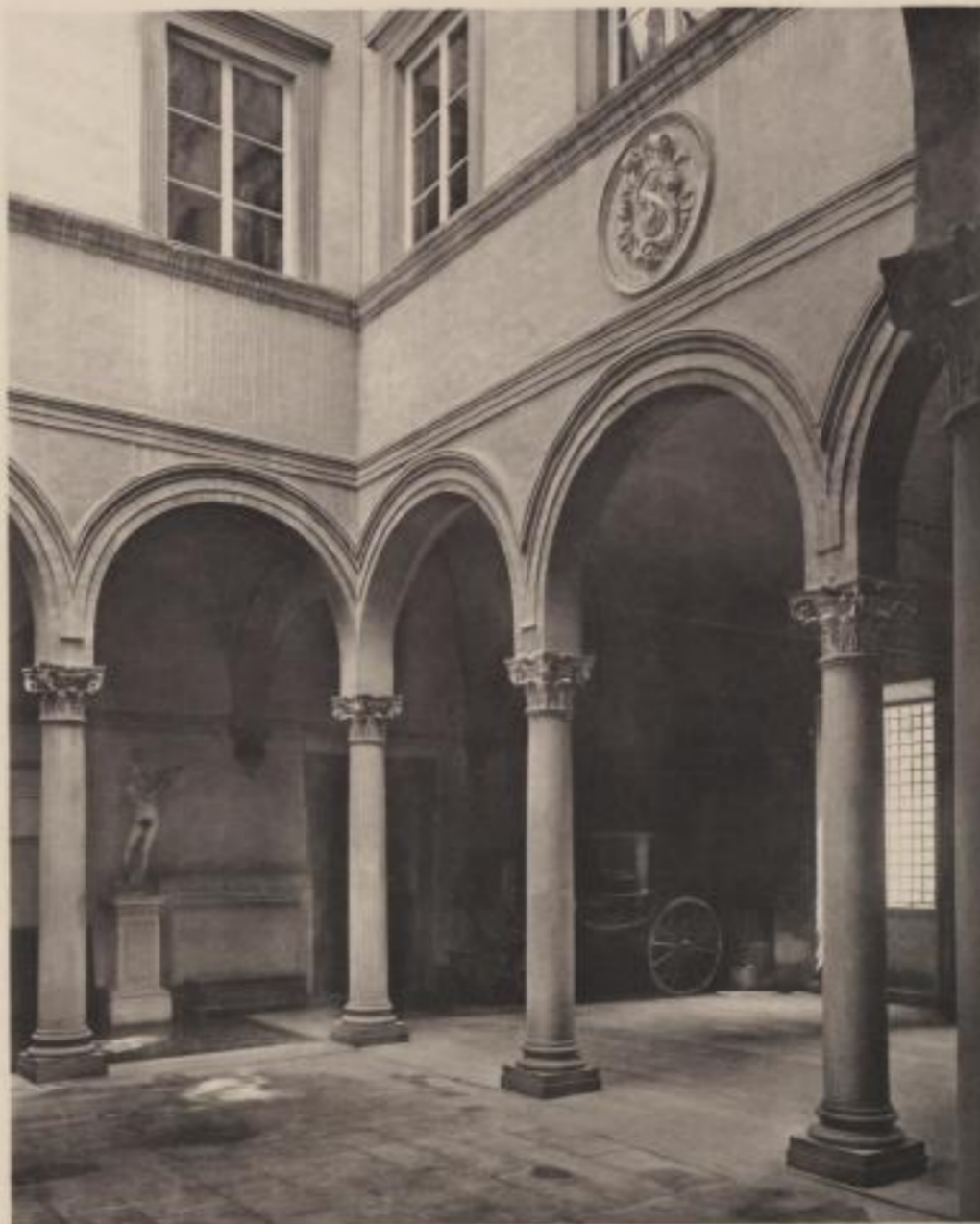
FIG. 27. HOF DES PALAZZO TORNUBUONI, JETZT CORSI, IN FLORENZ.
