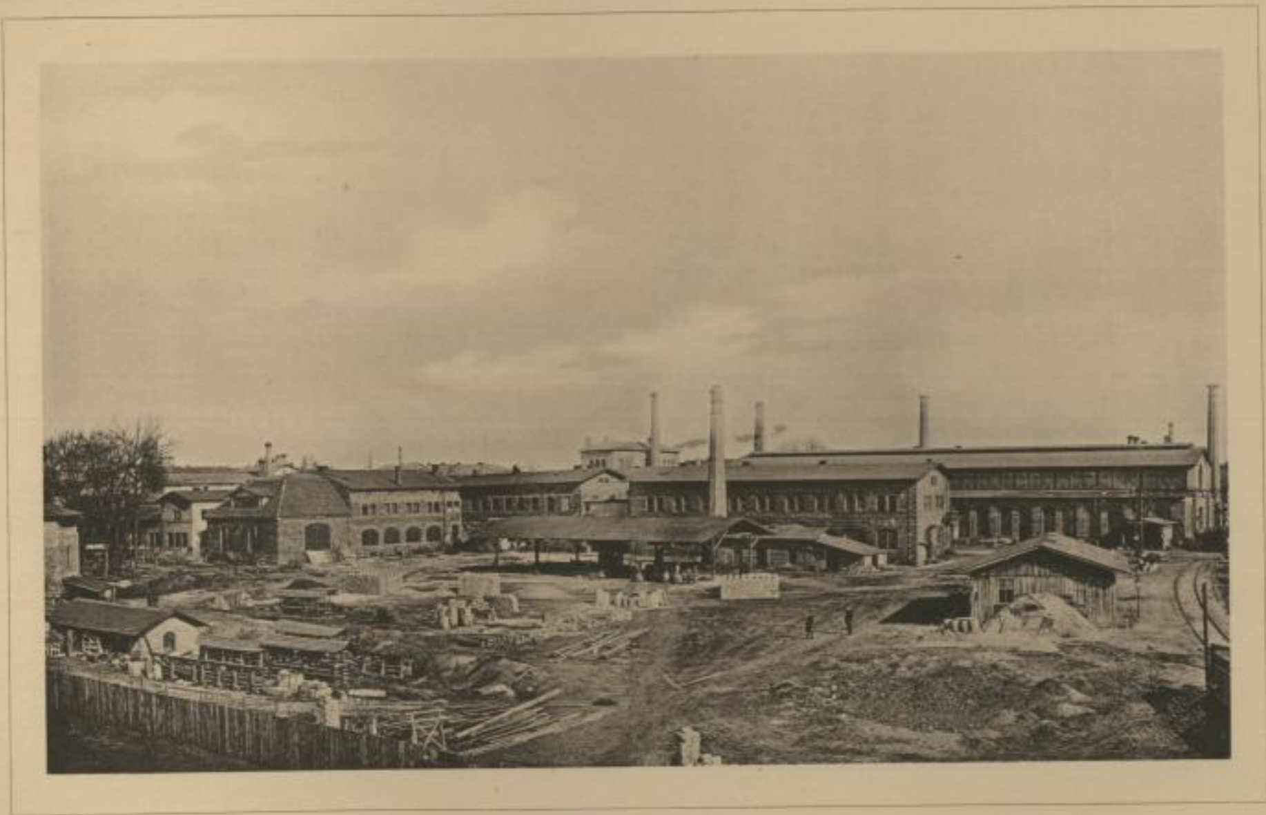
LAUCHHAMMER, VEREINIGTE VORMALS GRÄFL. EINSIEDEL'SCHE WERKE EISENWERK LAUCHHAMMER
