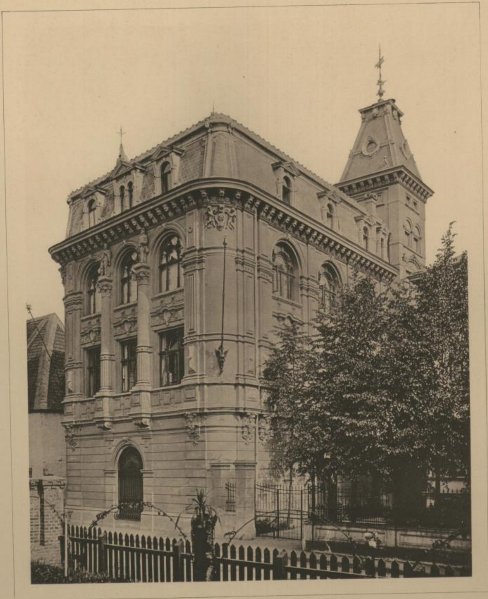
HARPENER BERGBAU-ACTIEN-GESELLSCHAFT IN DORTMUND DIRECTIONSGEBÄUDE
