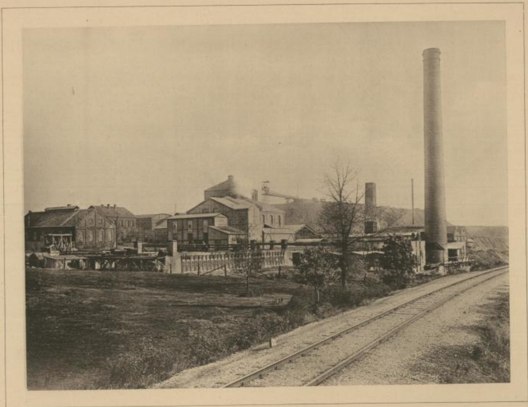
ACTIENGESELLSCHAFT ZECHEN DANNENBAUM IN BOCHUM DANNENBAUM-SCHACHT
