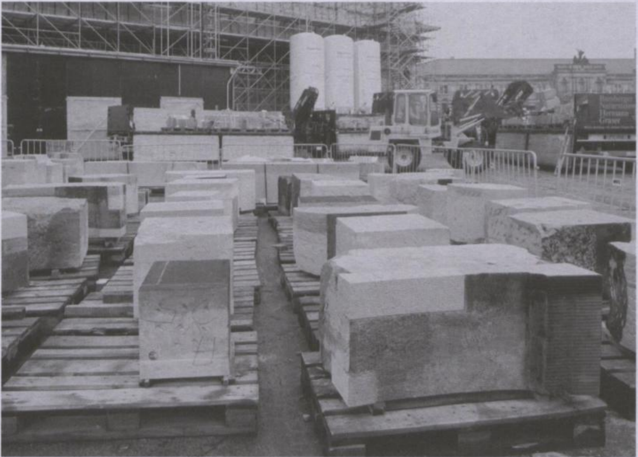
Restaurierte Fassadensteine auf der Baustelle, Foto Schöner 1998
