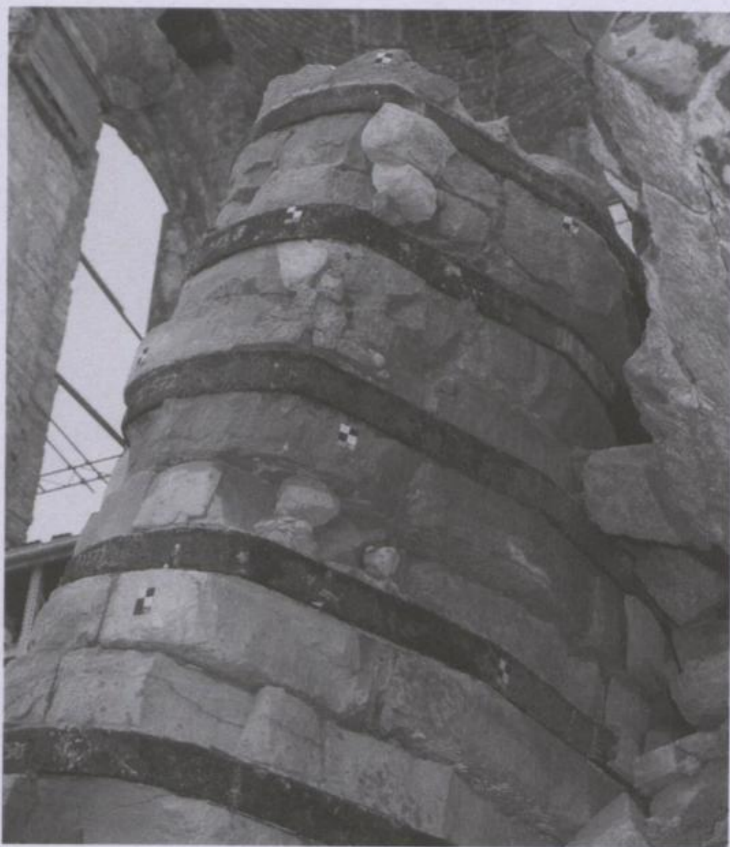
Bei der Enttrümmerung geborgener Pfeiler mit Stahlbandagen, Foto Albrecht 1993
