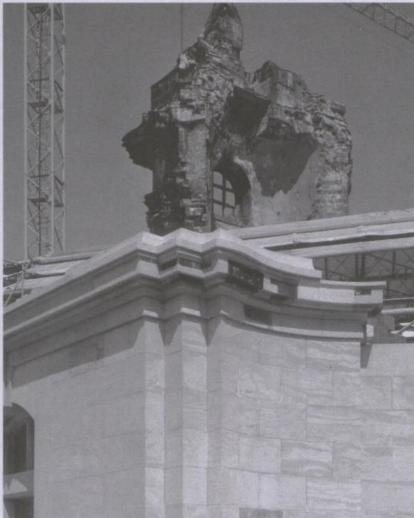
Neues Mauerwerk am Portal C, Foto Schöner 1996
