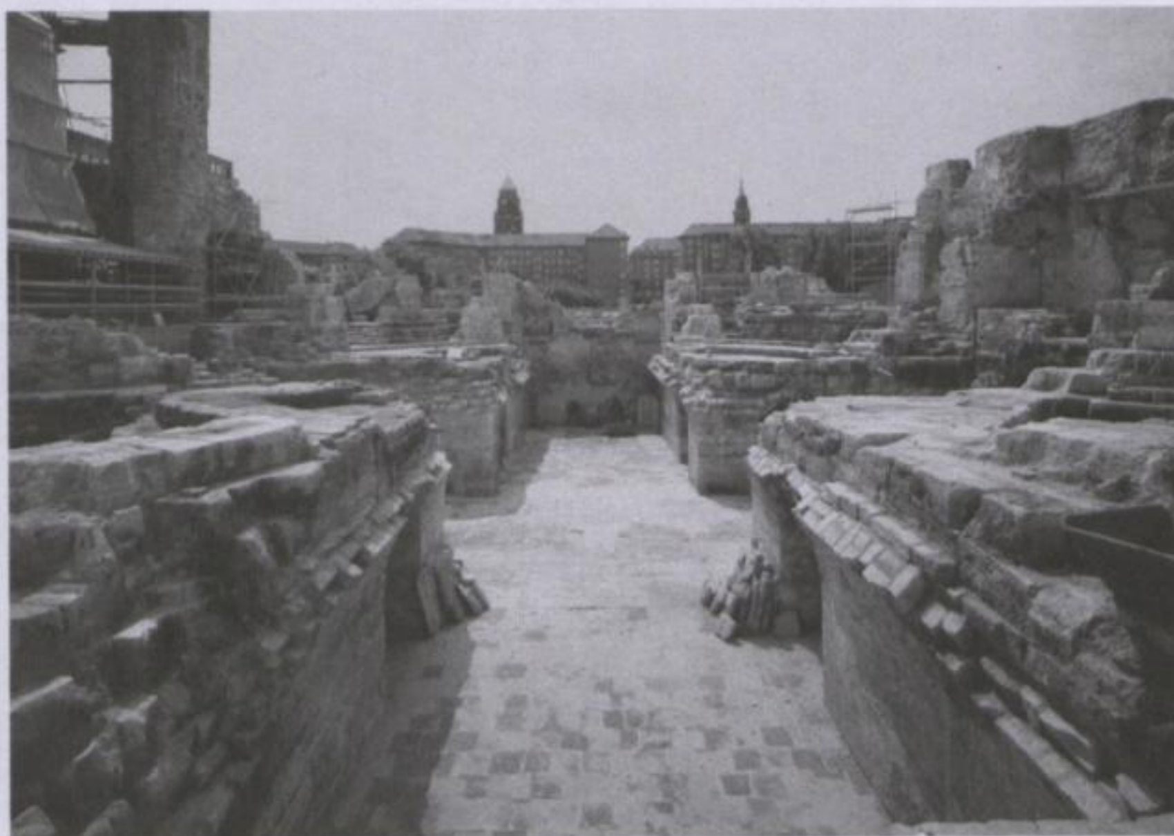
Kellergeschoß nach der Entrümmung, Foto Schöner Mai 1994
