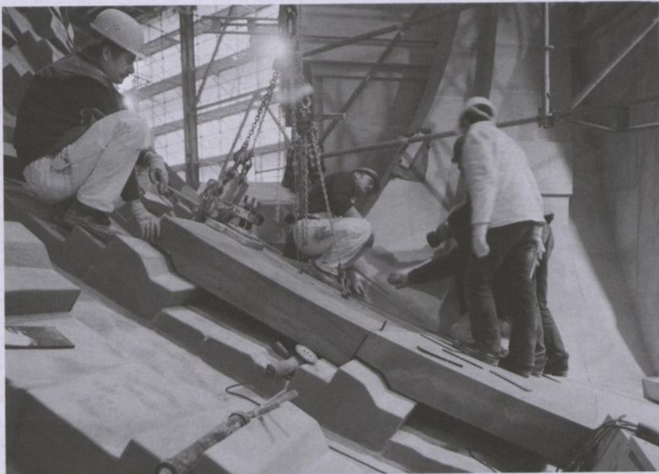
Versetzen einer Deckplatte am Kuppelanlauf, Foto Schöner 2002
