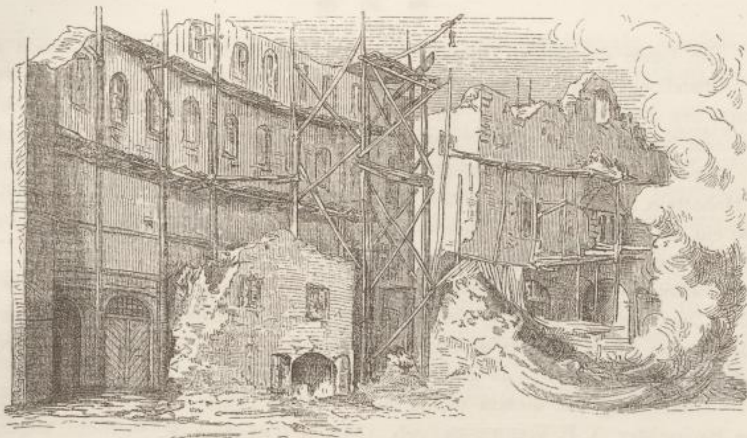
Abbruch des Trotzer der Pleissenburg.
