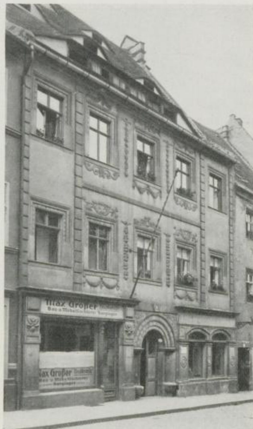
Abb. 178. Fassade Niedere Burgstraße 2
