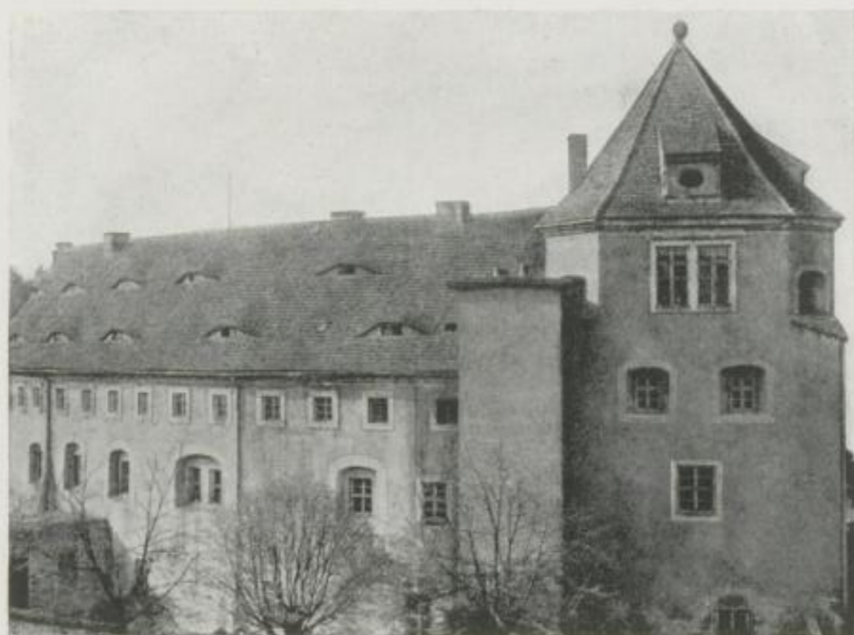
Abb. 25. Eckturm und Rundflügel der Festung vor dem Abbruch 1904
