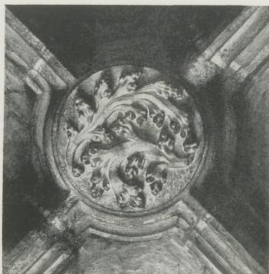
Abb. 134. Gewölbeflußstein in der Klosterkirche
