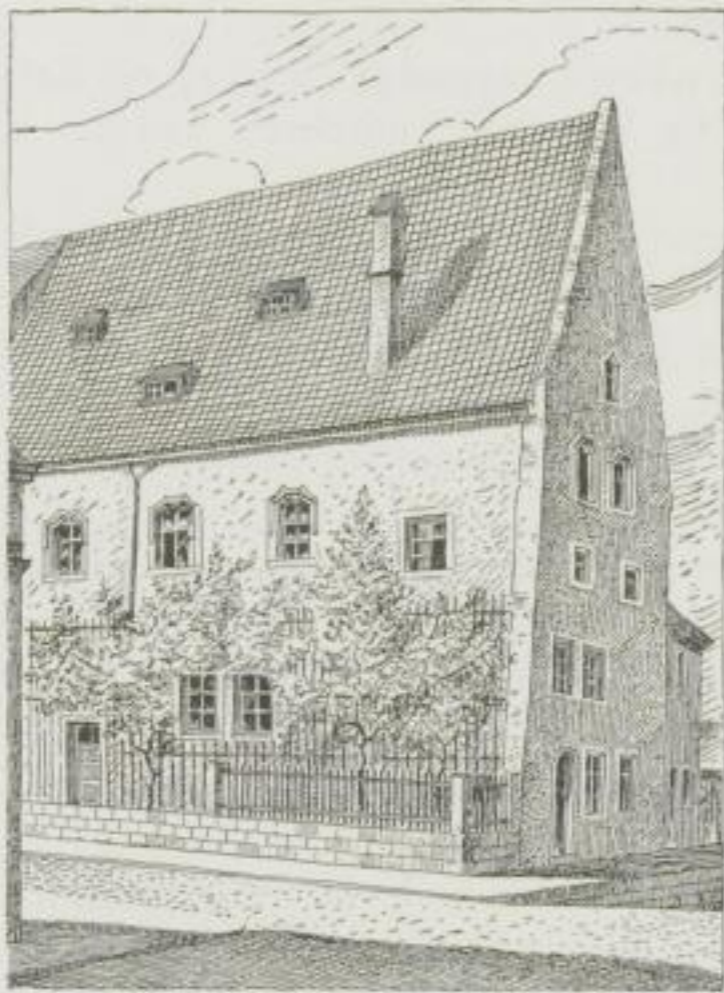
Abb. 126. Ehemaliges Klostergebäude an der Dohnaifchen Straße (abgebrochen 1894)
