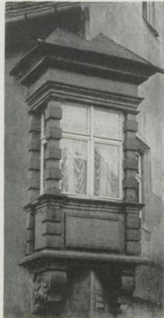
Abb. 182. Erker Lange Straße 38a
