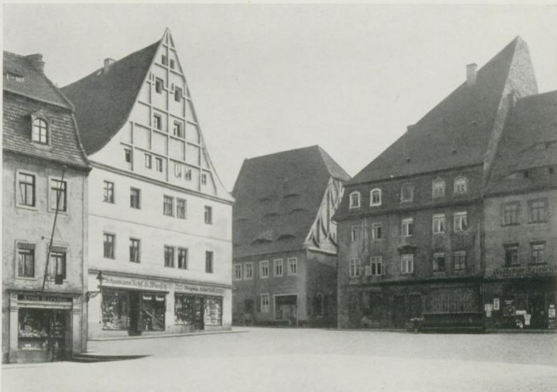
b) Die Südostecke des Marktes
