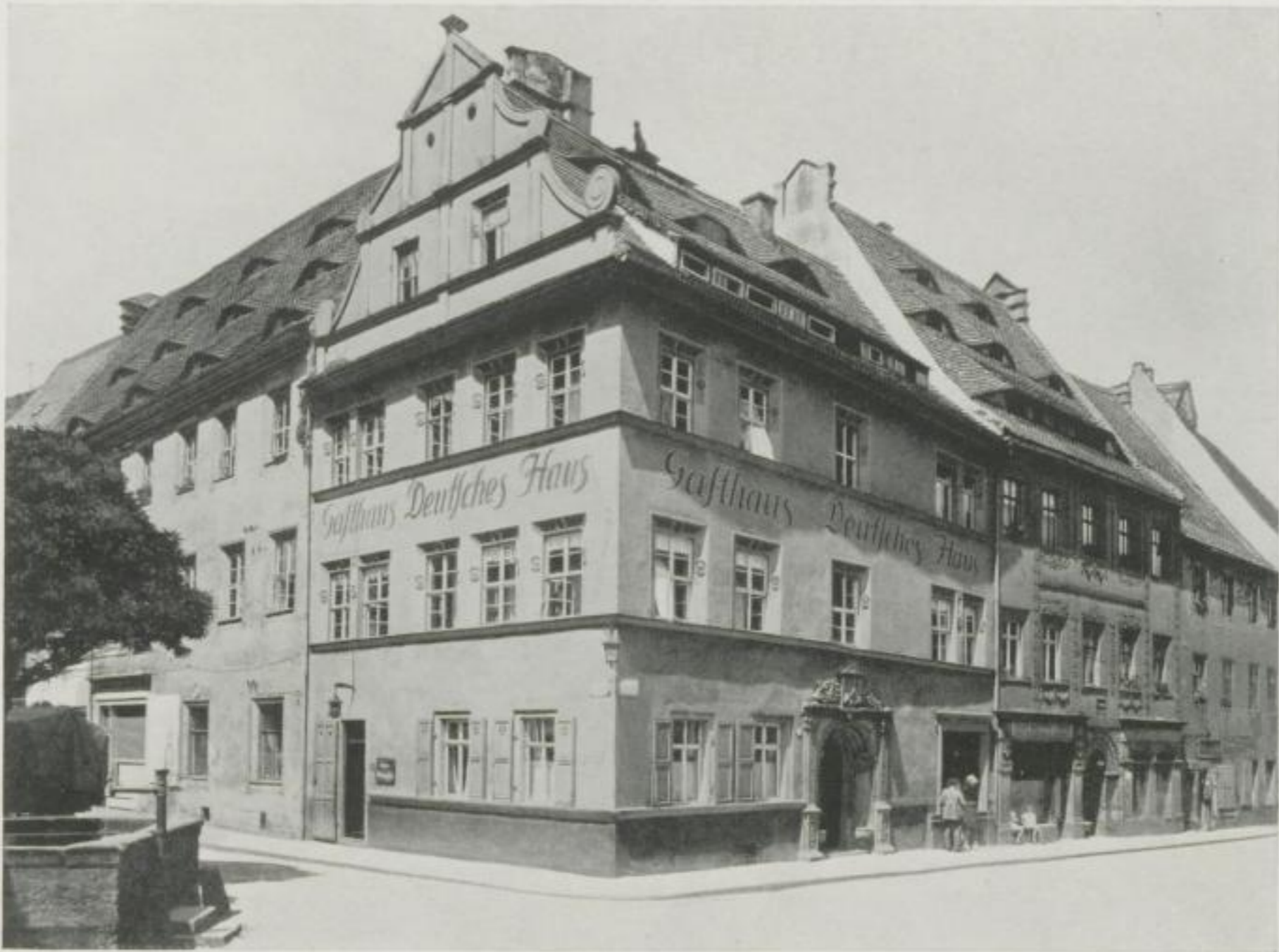
a) Das Wolf-Blechschmidt-Haus, Niedere Burgstraße 1
