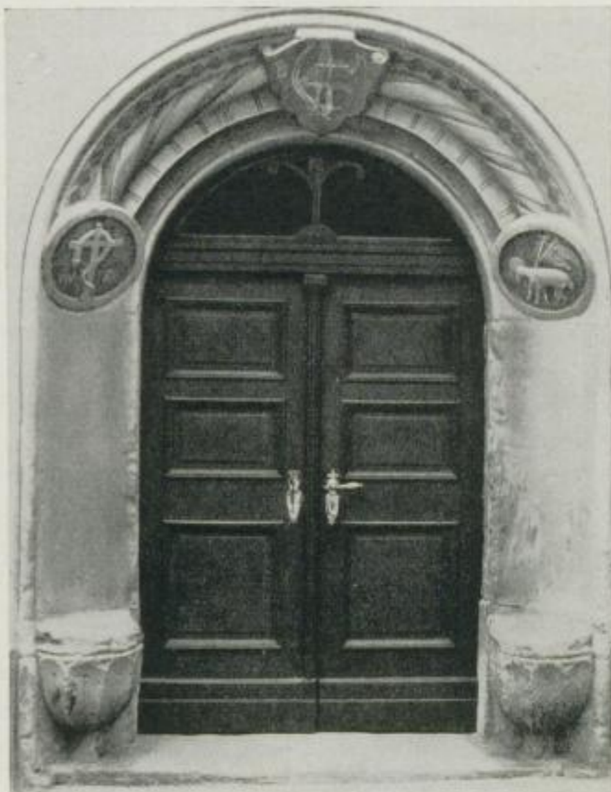
Abb. 169. Haustür Lange Straße 3
