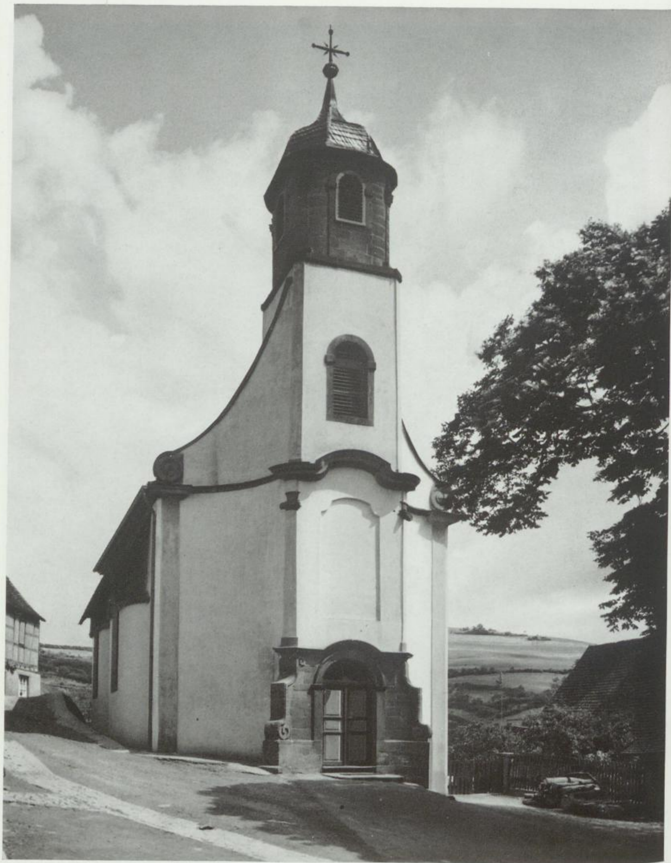
108. Schweisweiler, Kirche. Turmfront
