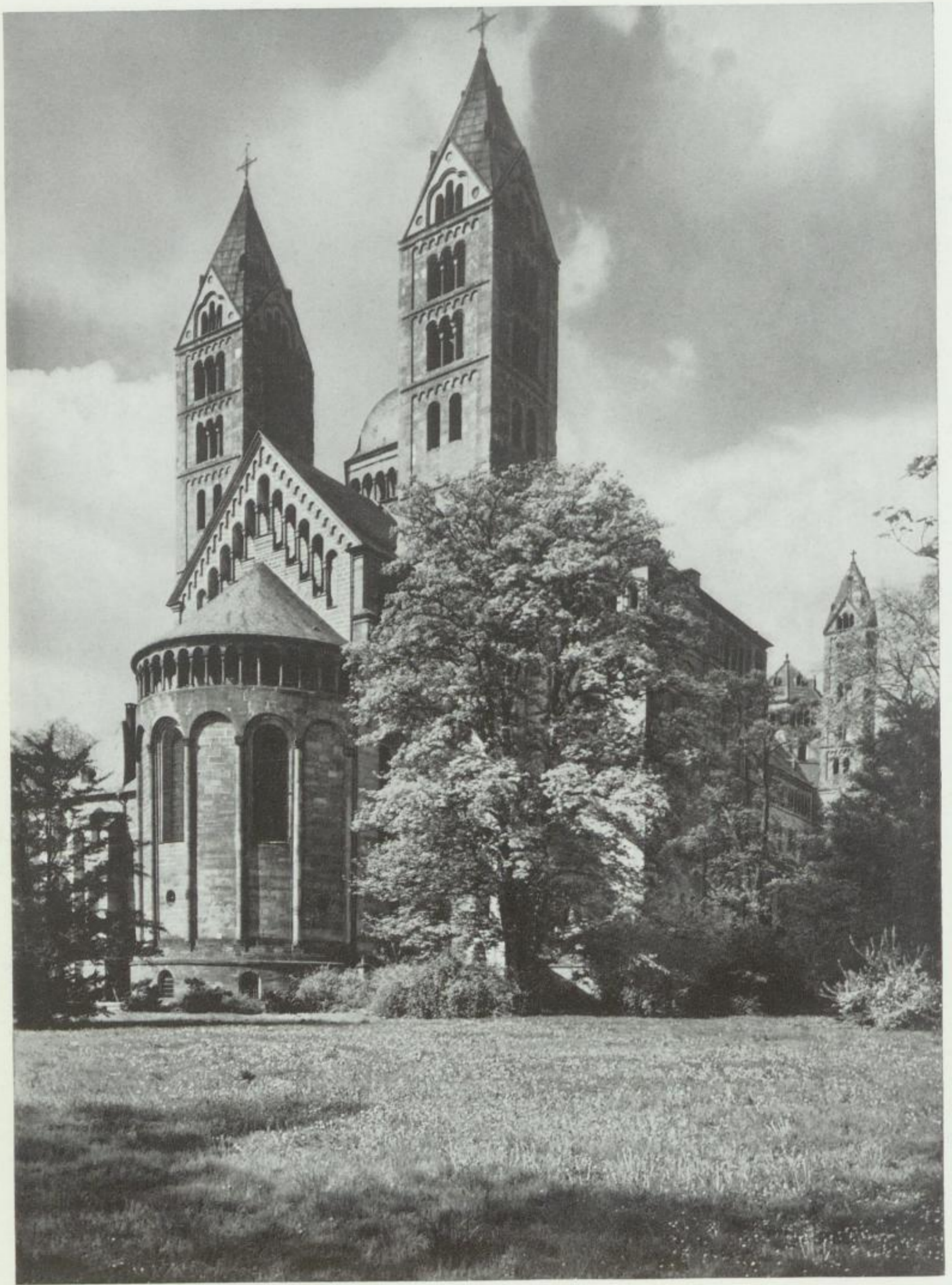
4. Speyer, Dom von Nordosten
