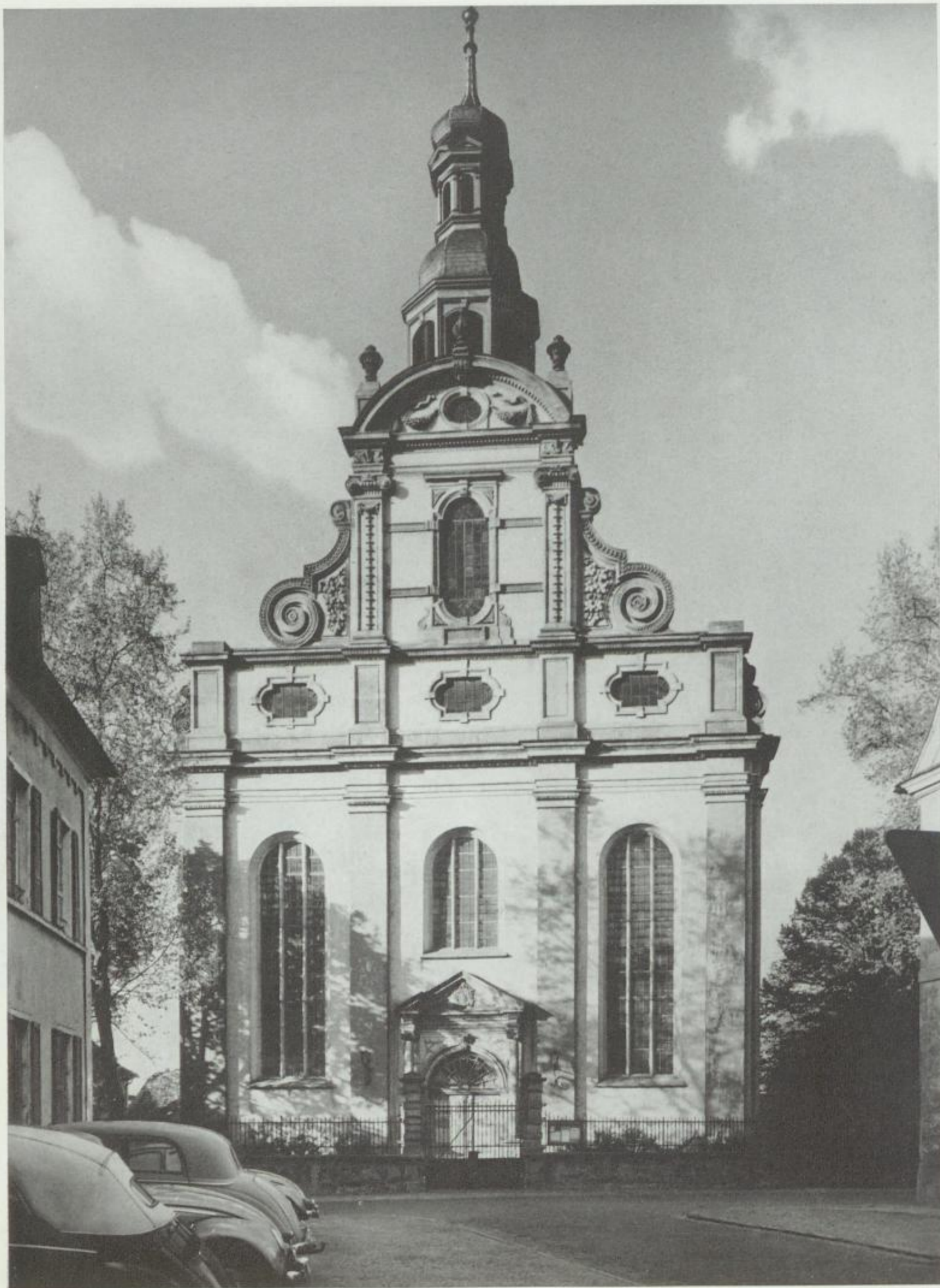
18. Speyer, Dreifaltigkeitskirche. Fassade
