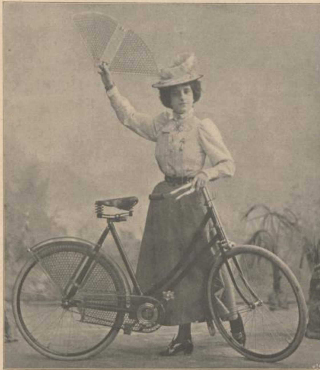
Fig. I. Damen-Rad mit Patent-„Genius“-Kleiderschutz und Kettenkasten.
