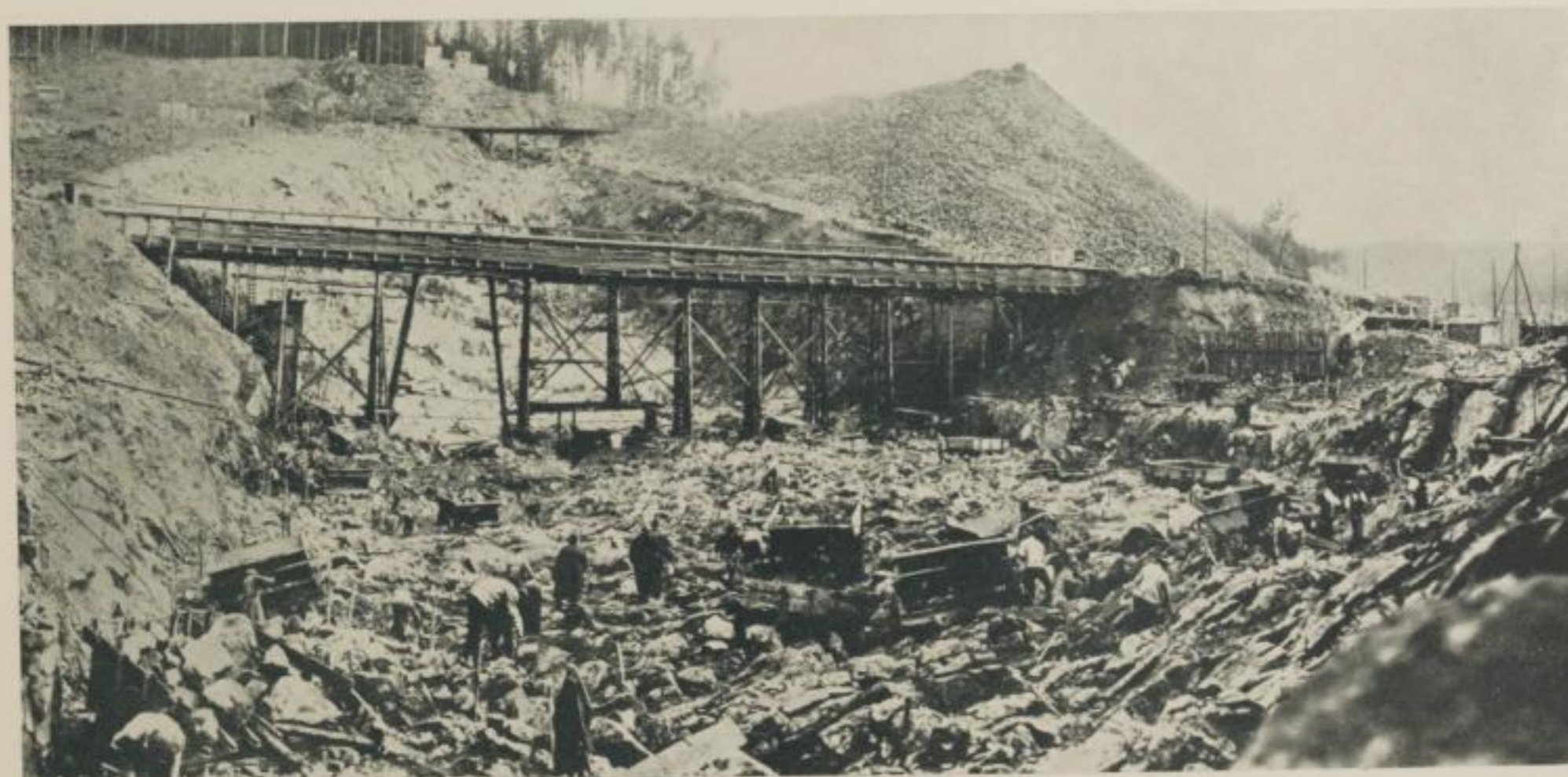
Baugrube vor dem Mauerbeginn im Mai 1931
