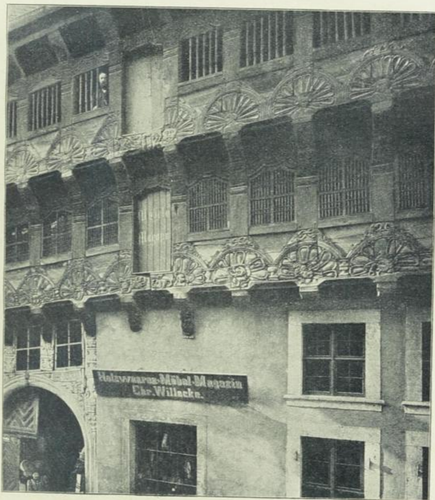
Abb. 57. Dom Hause Langestraße 9. Photogr. Verlag George Behrens, Hofkunsthandler, Braunschweig.
