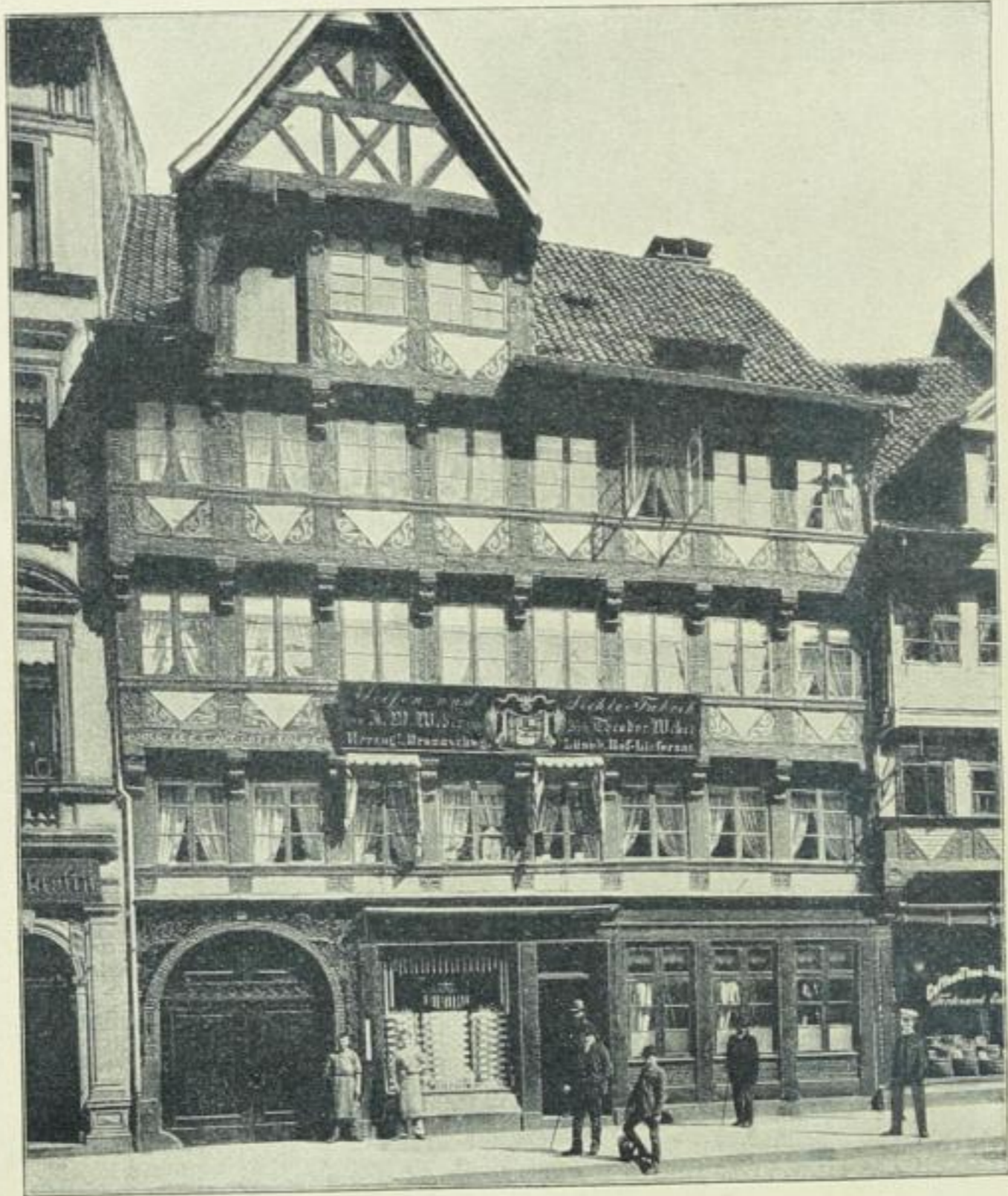
Abb. 60. Haus Steinweg 16. Photogr. Verlag George Behrens, Hofkunsthändler, Braunschweig.
