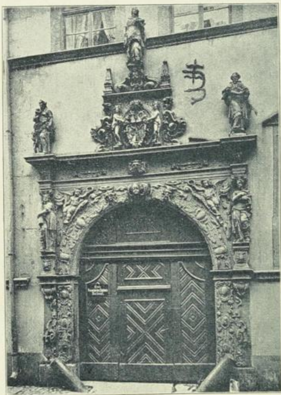
Abb. 36. Portal Reichenstr. 3. Photogr. Verlag George Behrens, Hofkunsthändler, Braunschweig.
