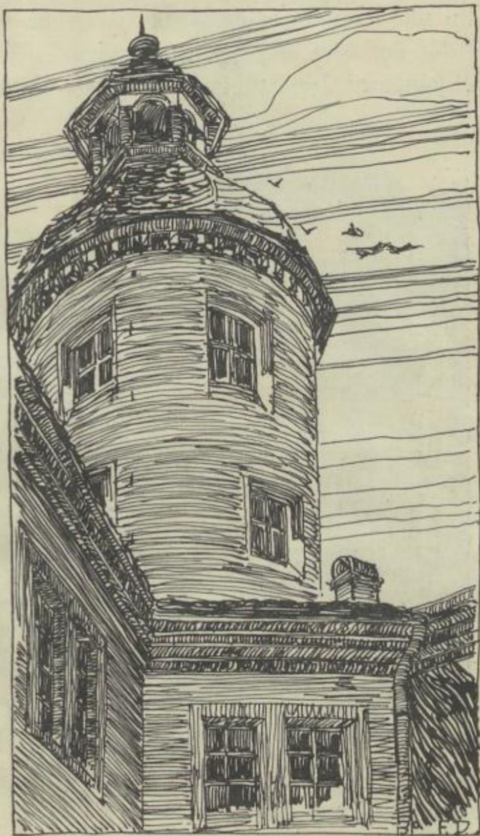
Treppenturm im Fürstenhaus.
