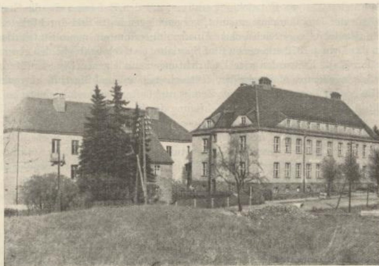
Bild 1. Das Eisenhütten-Institut mit dem 1954/56 errichteten zweiten Gebäude
