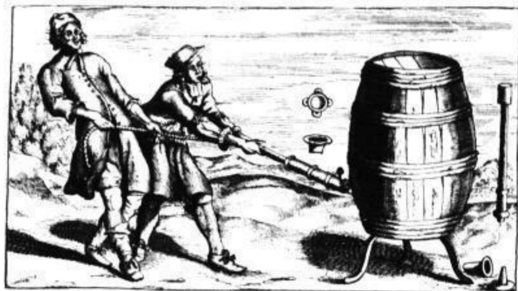
Otto von Guericke's Versuche zum Beweise des Luftdruckes Nach dem Bildnisse: Erforschung der Naturkräfte
