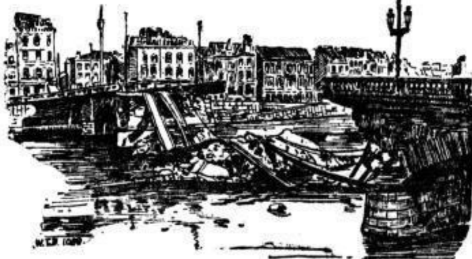
Der von den Belgiern gesprengte Pont des Arches über die Maas in Lüttich.
