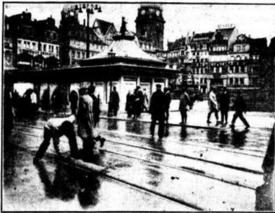
Das neue „Verkehrshäuschen“
