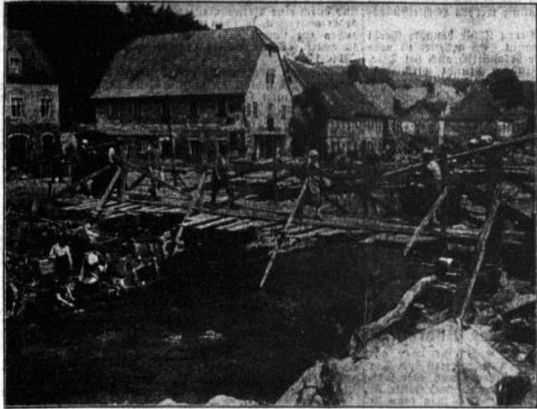
Die Errichtung von Notbrücken.
