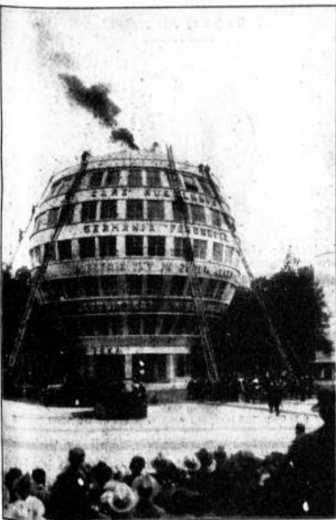
Das Riegelhaus brennt . . . Feuerwehrcübung am Riegelhaus in der Dresdner Jahreschau.
