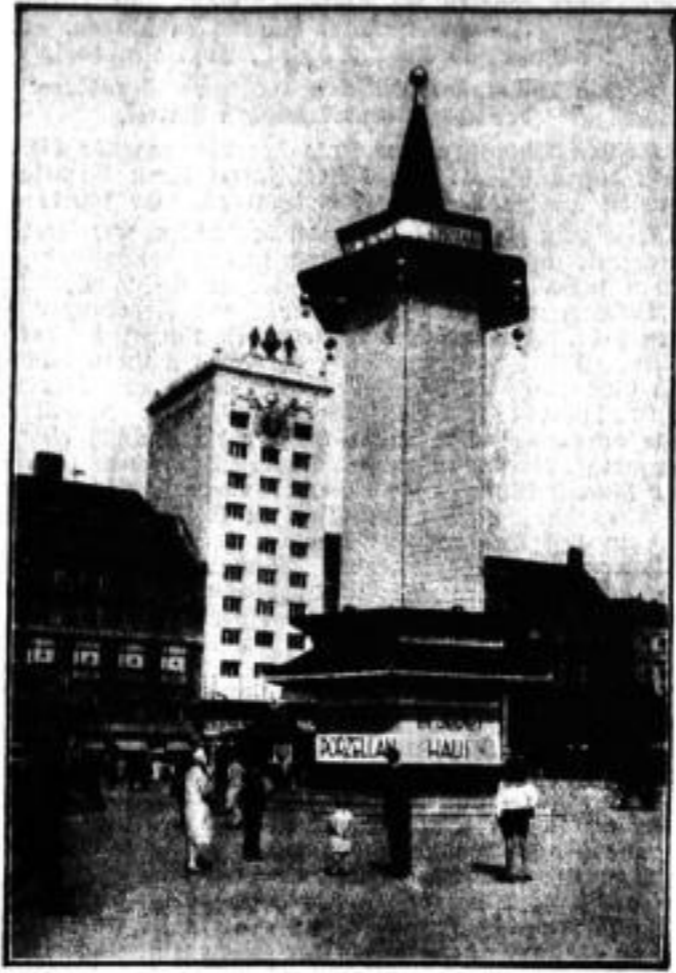
Der Porzellanturm, der mit Tausenden von Tassen umkleidet ist. Im Hintergrund Leipzigs erstes Hochhaus
