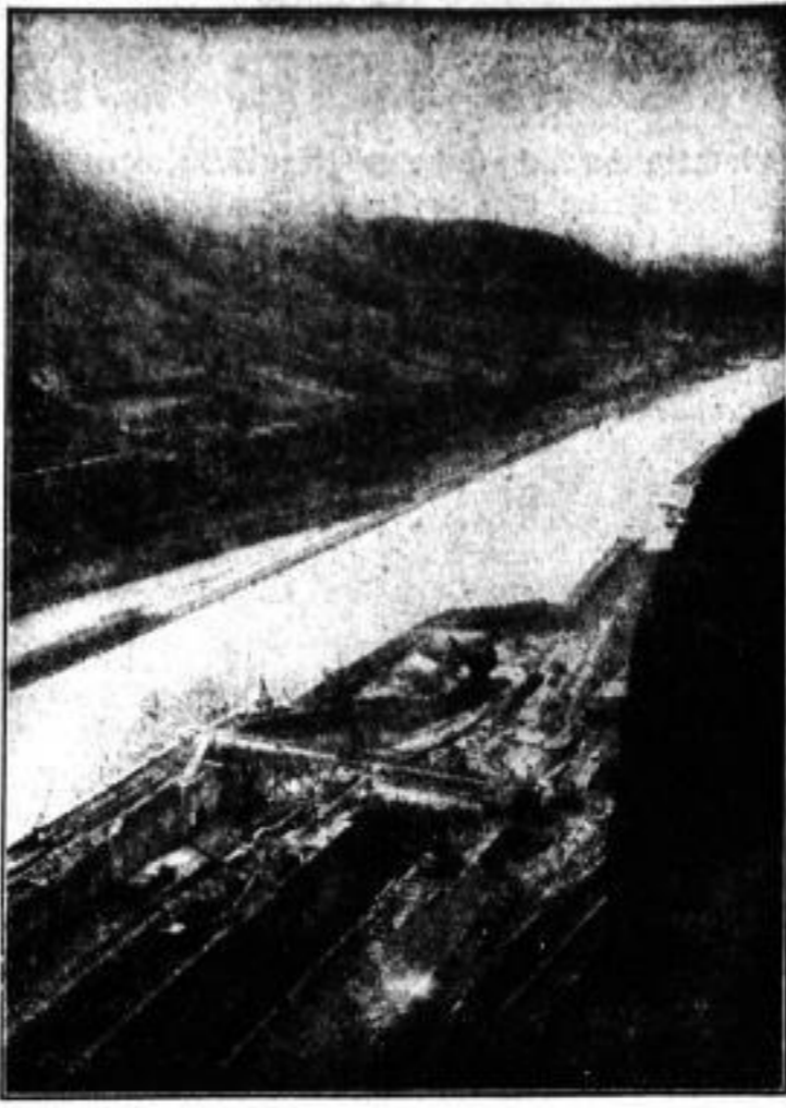
Das Riesenstauwerk am Fuße des Schreckenstein Das große Schleusenwerk der Elbe, mit dem der Wasserpegel um 5 Meter gehoben werden soll, ist das größte Stauwerk der Tschecho-Slowakei. Bild auf die Sperrmauer und in die Schlenstammern vom Schreckenstein aus
