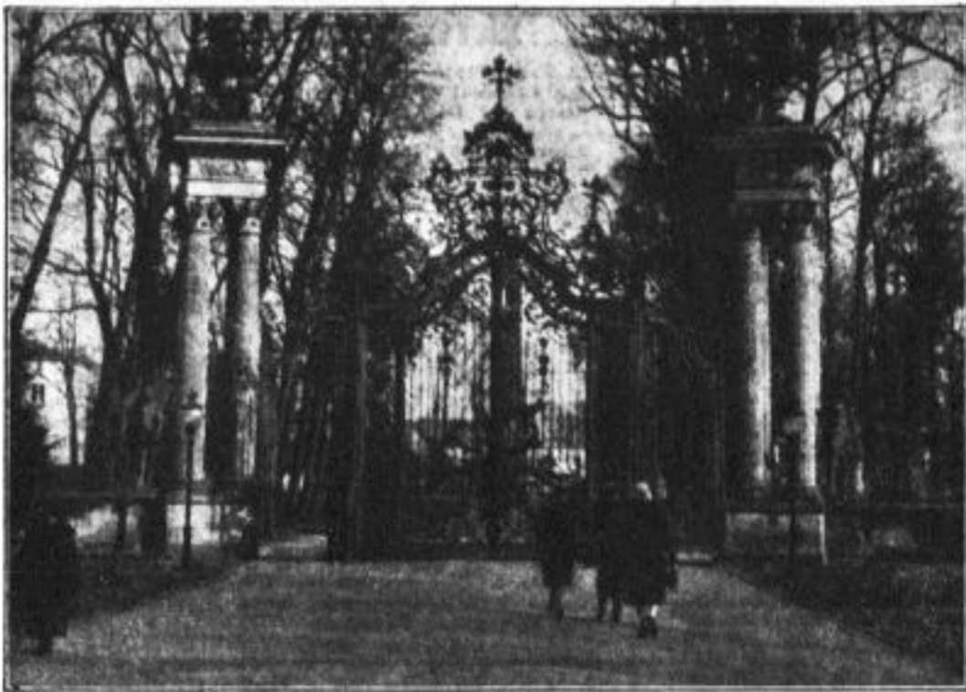
Das Haupteingangstor zum Park von Saxe-Coburg soll verschwinden
