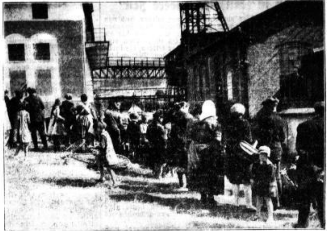
Sinterblebene vor dem Rutzschacht, die immer noch auf Nachricht warten
