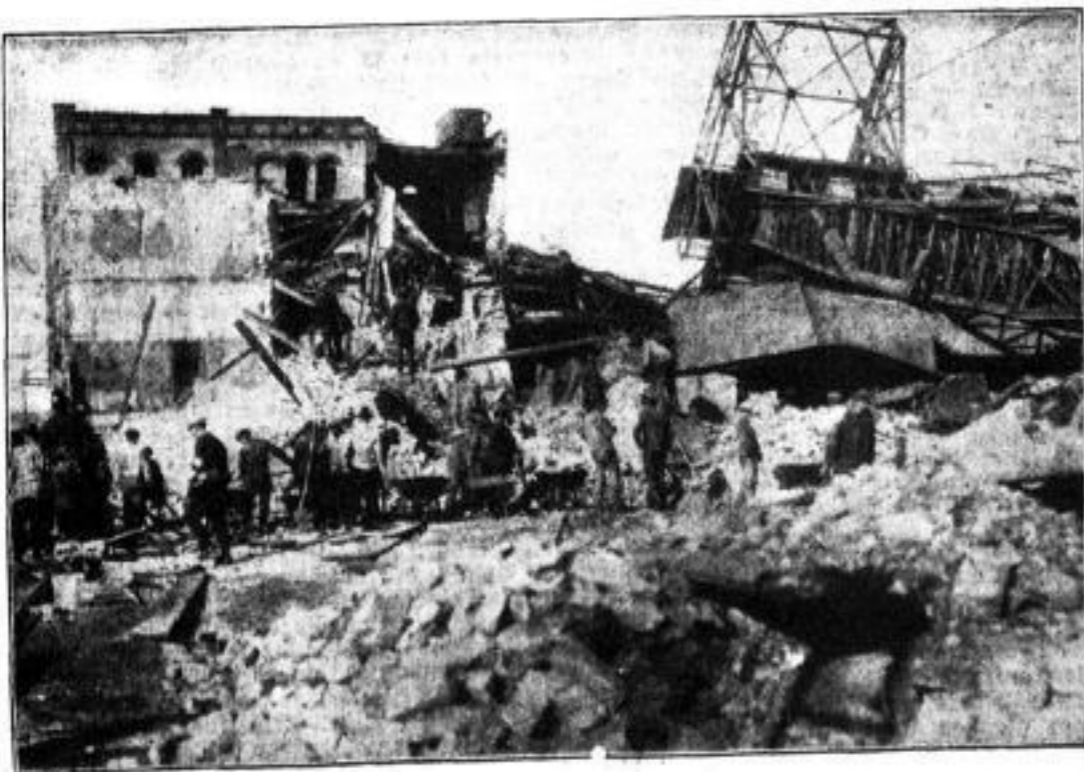
Das zerstörte Verwaltungsgebäude und der eingestürzte Fördertrium
