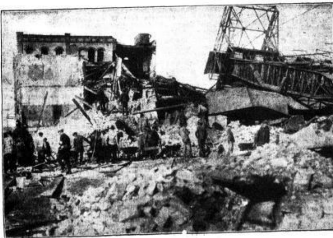
Das zerstörte Verwaltungsgebäude und der eingestürzte Fördertrium
