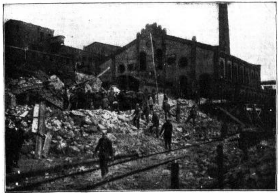
Die Rettungsmannschaften am Eingang zu der zerstörten Förderanlage des Schachtes Anna II
