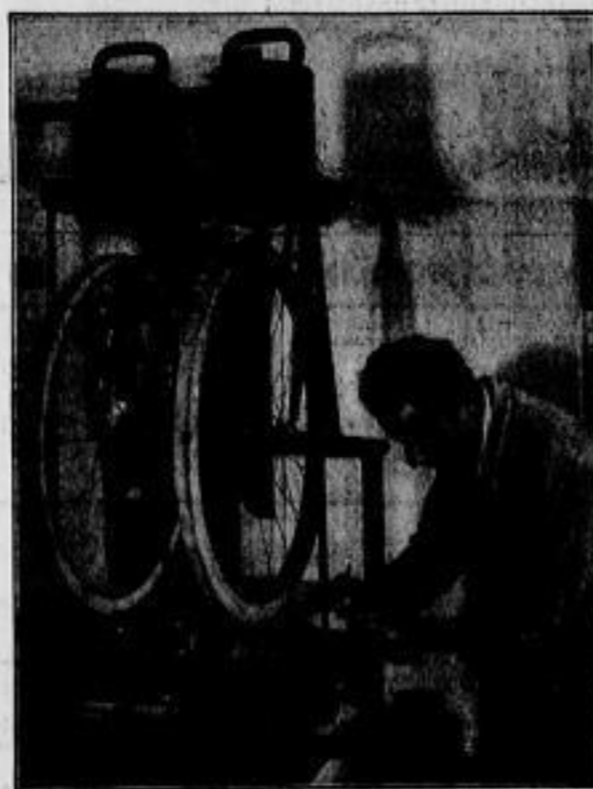
Wie lange hält die Bereifung eines Landbriefträger-Fahrrades? Welcher Reifen wird am wenigsten abgenutzt? Diese Apparatur im Reichspostzentralamt in Berlin dient zur Feststellung der Haltbarkeit von Fahrradreifen. Die beiden Gemische (oben) entsprechen der Belastung des Fahrrades durch den Briefträger; unter den Rädern befindet sich die „wandernde Schaufel“, die durch die Apparatur in Bewegung gesetzt wird. Die zurückgelegte Kilometerzahl kann auf dem Tachometer (rechts unten) abgelesen werden.
